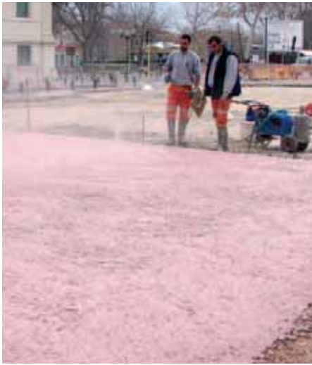
Une fois le béton en place, un produit désactivant est appliqué sur toute la surface.
