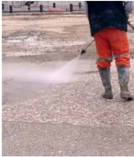
La surface du béton est ensuite nettoyée au jet à haute pression.
