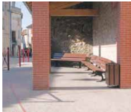
Trouillas : pour ses espaces piétons, la commune a fait appel au béton désactivé, calepiné de briquettes rouges.
