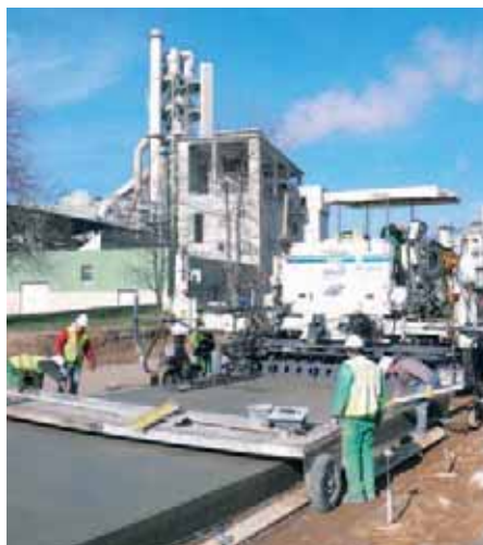
La machine à coffrage glissant avec sa lisseuse automatique à l'arrière.
