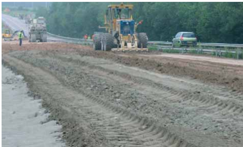
Scarification et préparation de la couche de forme, avant épandage du ciment et malaxage du sol à traiter.
