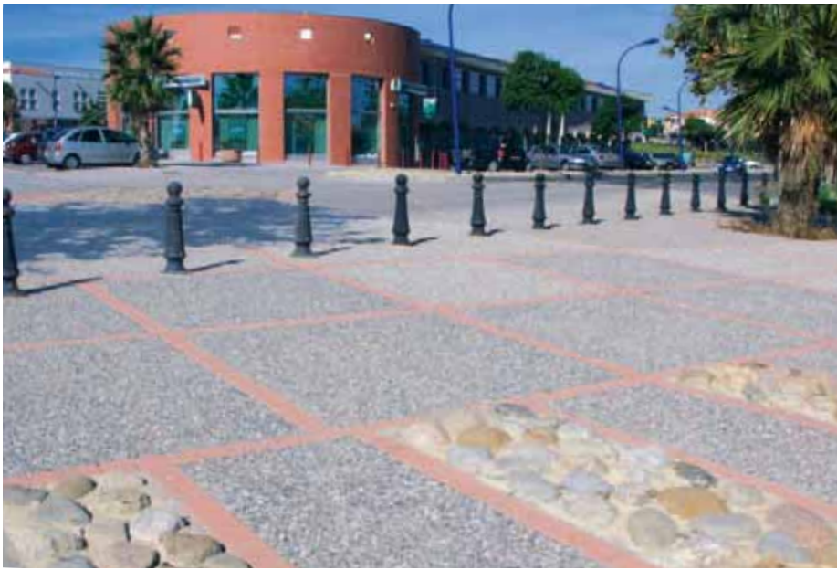
Cabestany : le béton désactivé composé de deux granulats différents, les gros galets et le calepinage de couleur brique sont en parfaite harmonie.
