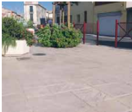
Trouillas : le parvis de la mairie a été réalisé en béton imprimé à motif de dalles en pierres de formats différents.
