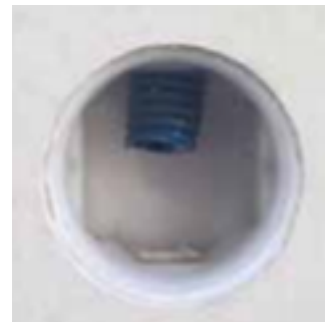
Pots et gaines électriques
