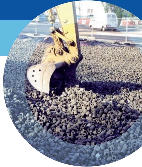
La mise en œuvre d'Hydrocyl® est aisée : déversement des cylindres en vrac, mise en place d'une grave d'égalisation puis une seule opération de compactage.
