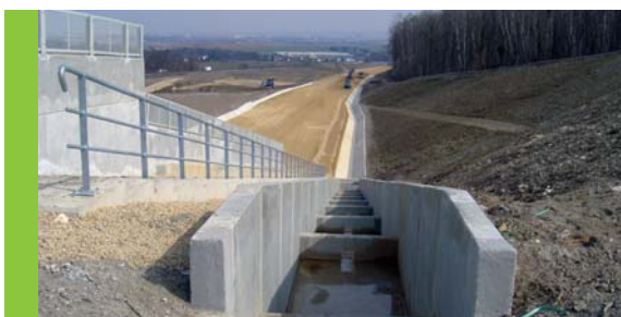
Descente d'eau et fossé pour plateforme LGV
