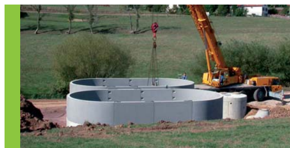
Construction d'un bassin en béton préfabriqué
