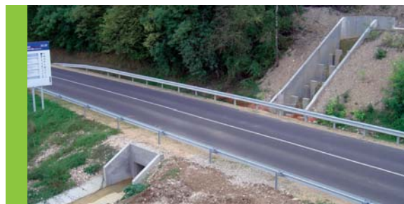
Descente d'eau en cascade
