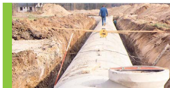
Canalisation en béton de grand diamètre posée en tranchée
