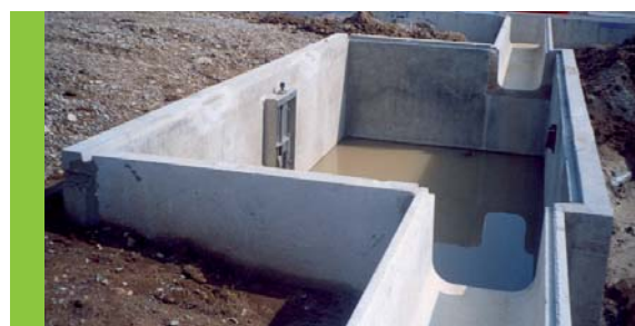
Bassin de rétention en éléments préfabriqués en béton assemblés sur site
