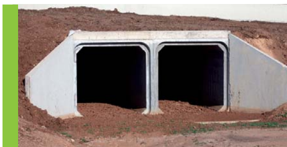
Cadre double en béton sous chaussée
