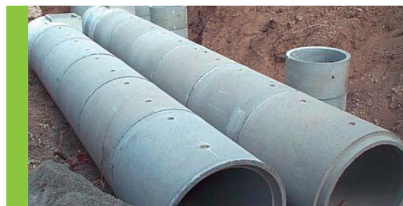
Stockage des eaux dans des canalisations en béton de grandes dimensions
