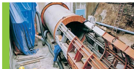
Canalisation en béton de grand diamètre posée par fonçage
