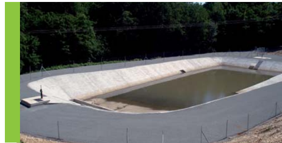
Bassin de rétention autoroutier
