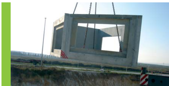
Pose de cadres préfabriqués en béton
