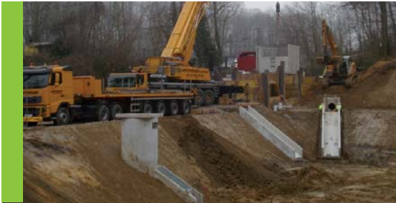
Ouvrage de régulation en construction
