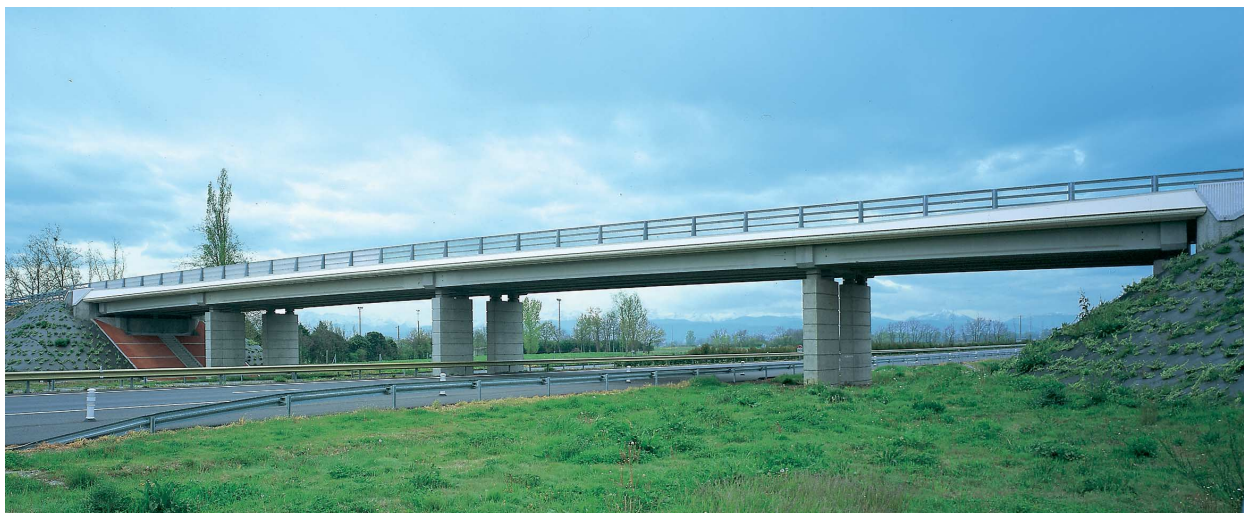
L'un des franchissements de l'A64 (reliant Muret à Saint-Gaudens) dessiné par les architectes Faup et Zirk.
