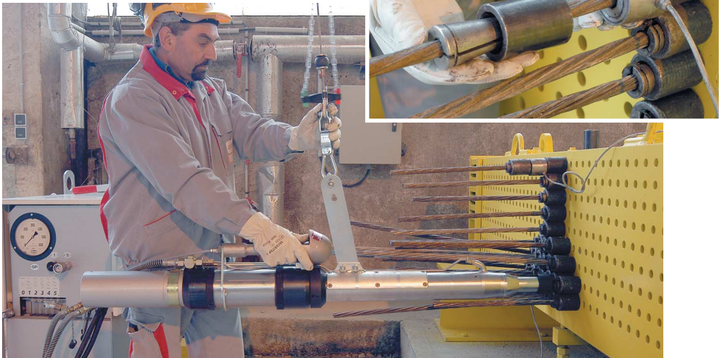
Mise en tension d'un toron de précontrainte.
