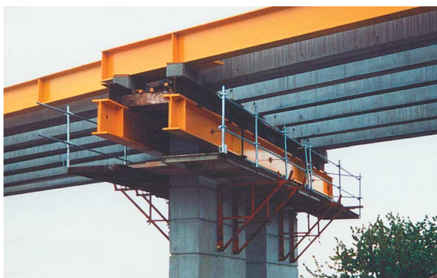
Dispositif d'étaie sur pile.
