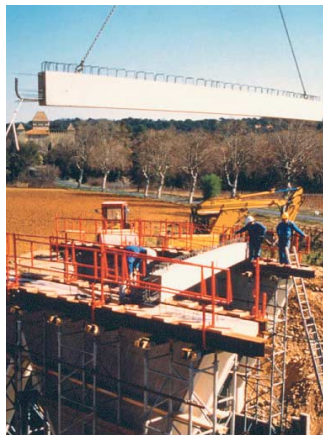
Mise en place des poutres.
