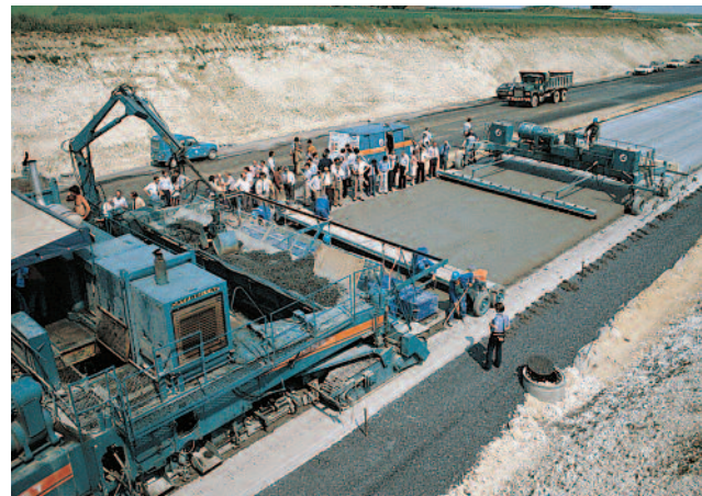
Revêtement en béton à joints non goujonnés: vue générale de l'atelier de mise en œuvre du béton.
