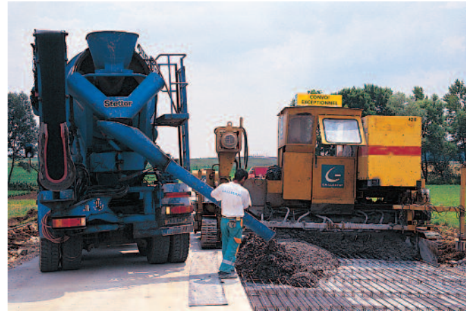
Chaussée composite en BAC/GB : le béton est déversé par la toupie à l'avant de la machine à coffrage glissant.
