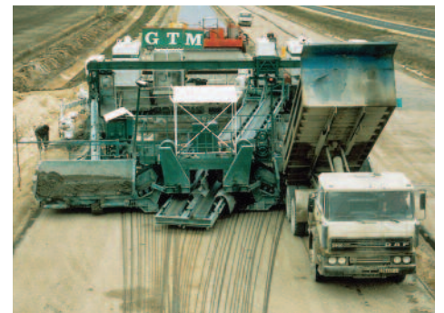
Chaussée autoroutière en béton armé continu (BAC) : atelier de mise en œuvre.
