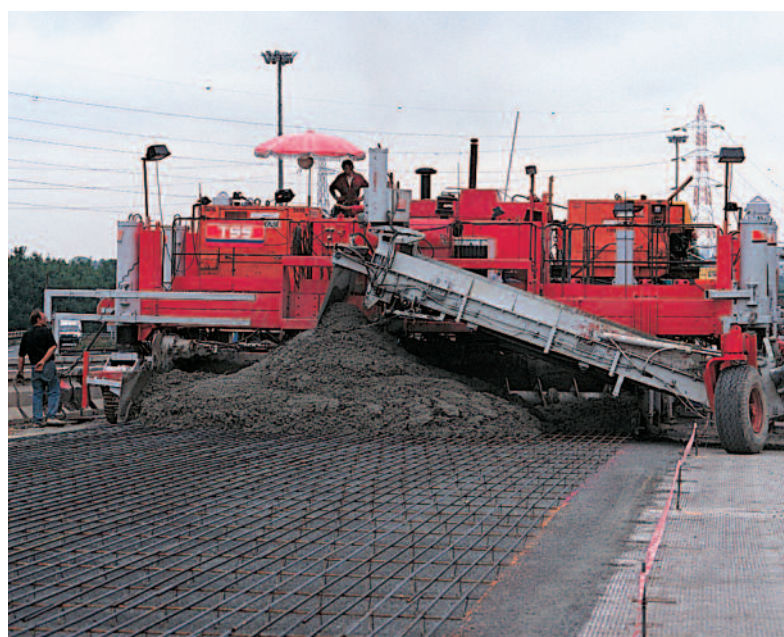
Chaussée composite en BAC/GB : le béton est déversé devant la machine par un alimentateur.
