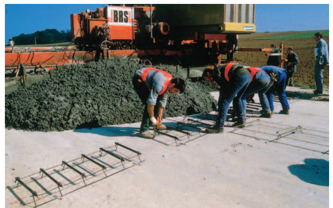
Revêtement en béton à joints goujonnés: installation à l'avancement des « paniers » à goujons.
