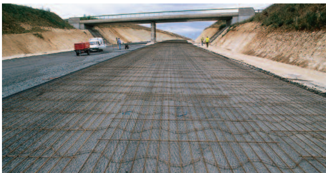
Chaussée composite en BAC/GB : avant le bétonnage, les armatures du BAC sont positionnées, au-dessus de la grave-bitume, à mi-hauteur du revêtement béton.
