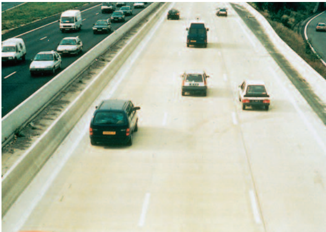
Chaussée autoroutière en béton armé continu (BAC): solidité, confort et durabilité.
