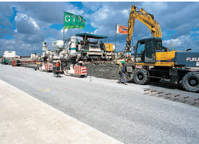
Revêtement en béton à joints goujonnés : atelier de mise en œuvre.
