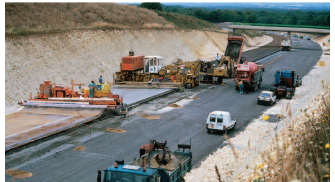
Déviations des Rassats-Favrauds RN 141. Vue d'ensemble de l'atelier de mise en œuvre du BAC/GB : machine à coffrage glissant suivi d'une rampe assurant la pulvérisation du produit retardateur de prise et le déroulage de la feuille de polyéthylène.
