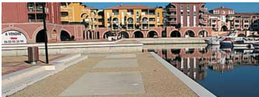
La voirie urbaine : modernité et intégration au site.
