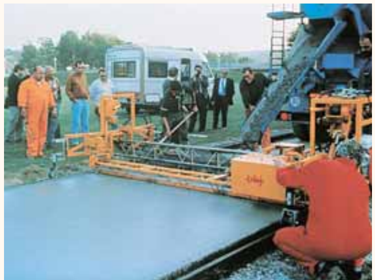
Mise en œuvre au vibro-finisser.
