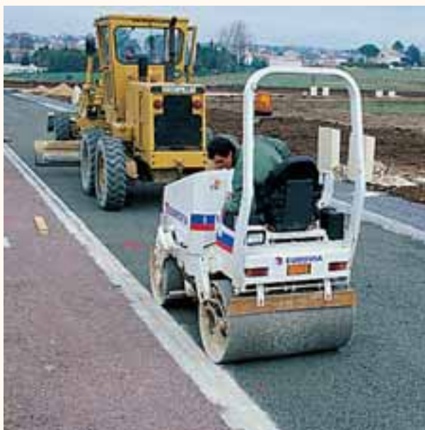
Mise en œuvre du béton poreux à la niveleuse et au compacteur.
