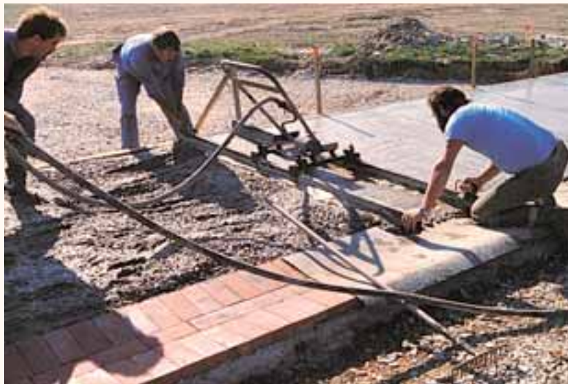
Mise en œuvre à l'aiguille et à la règle vibrantes.
