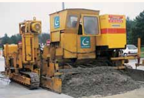
Mise en œuvre à la machine à coffrage glissant.
