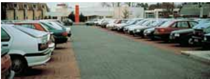
Revêtement d'une chaussée réservoir réalisé avec des pavés en béton perméables à l'eau.
