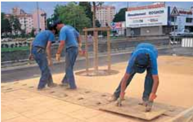
Béton imprimé : application des matrices.
