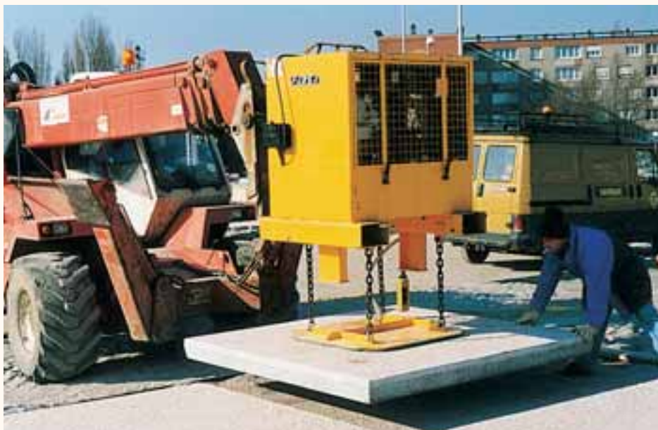
Pose par ventouses.
