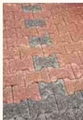
Chaussées réservoir avec revêtement en pavés.
