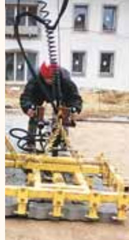
Pose des pavés à la machine.
