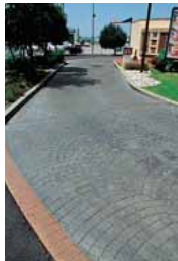
Revêtement à fonction d'intégration à l'environnement : le béton imprimé.
