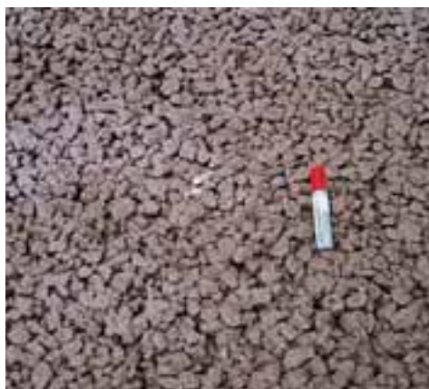
Aspect d'un revêtement en béton drainant.
