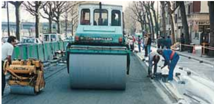
Mise en œuvre d'un revêtement en béton drainant.
