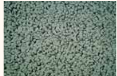
Aspect de surface d'un béton drainant.
