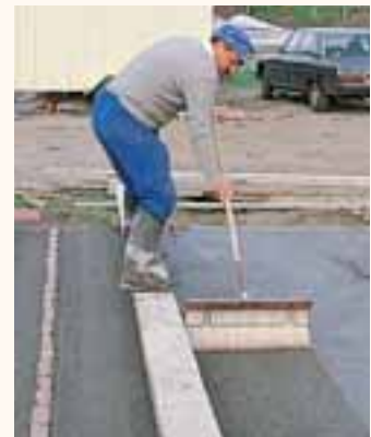
Brossage du béton.
