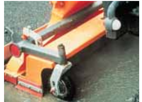
Détail du traineau d'aspiration des boues de décolmatage.
