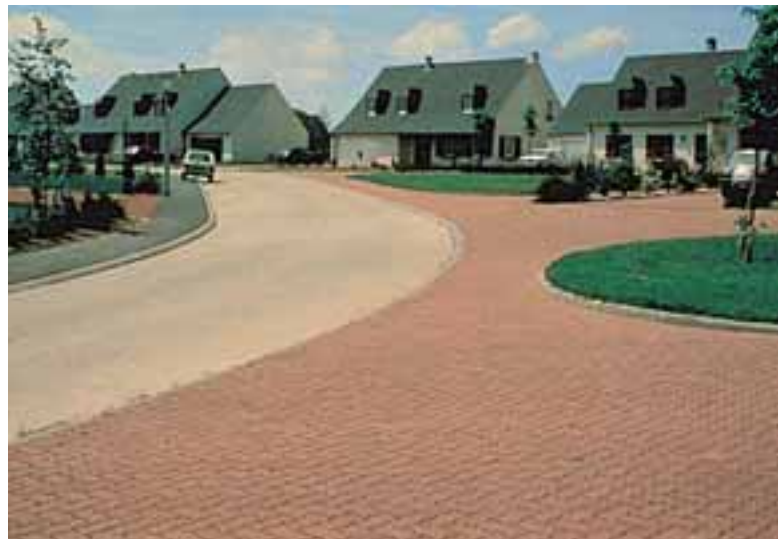
Aménagement urbain : utilisation judicieuse et complémentaire du béton coulé en place et des pavés béton.
