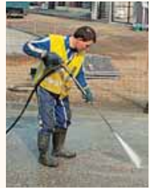
Béton désactivé : lavage au jet d'eau.
