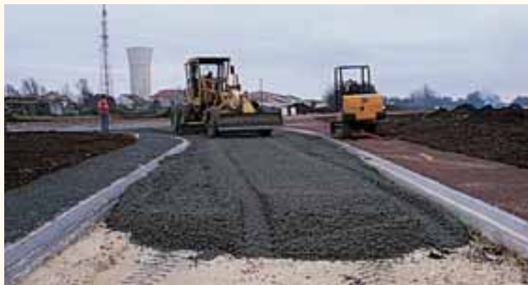
Mise en œuvre du béton poreux.
