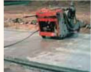
Réalisation d'un joint scié.
