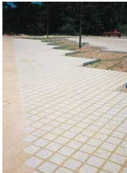
Revêtement en pavés béton à joints larges.
