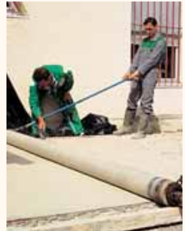
Mise en œuvre au striker.
