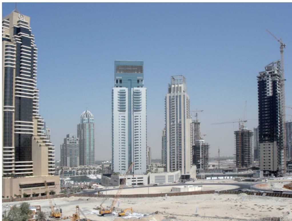
Un groupe de tours en construction à Dubaï en 2006.
