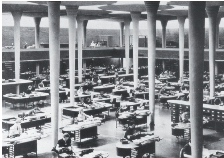
SC Johnson and Son, Racine, Wisconsin, 1936-1939, Frank Lloyd Wright. Le bâtiment de briques sans fenêtres remplit tout un bloc dans un environnement peu attrayant. Des tuyaux transparents en matière plastique remplissent la surface du toit entre des colonnes en forme de champignon. Ces mêmes tuyaux relient les murs extérieurs au plafond, comme des traits de lumière et forment les cylindres des ascenseurs.
