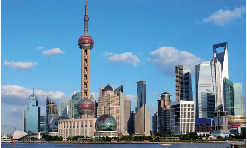
Vue générale des IGH de Shanghai.
