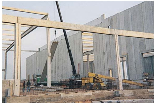
Entrepôts CGM, façades à base de murs en dalle alvéolées.
