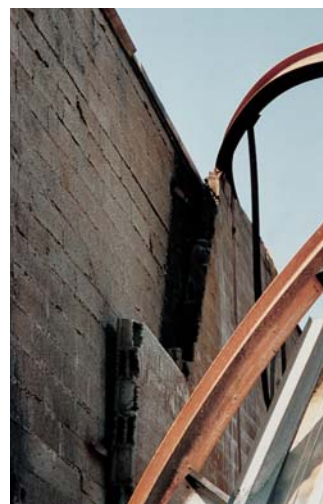
mur séparatif coupe-feu constitué de deux parois indépendantes
