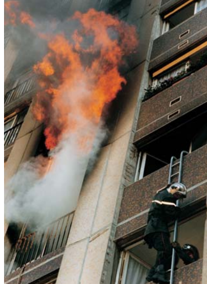
Feu dans un appartement, Saint-Ouen, 1997. Sans mesures préventives, le feu peut facilement cheminer d'un étage à l'autre par transmission directe, passage des gaz chauds ou rayonnement (application des articles CO 19 à 22 du règlement de sécurité incendie).
