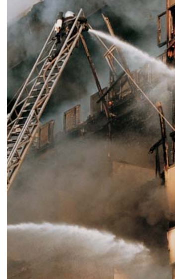
Feu dans un bâtiment dont l'ossature est en béton et la façade en éléments légers. La structure a parfaitement résisté.
