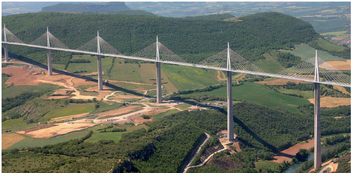
Viaduc de Millau, A75, vallée du Tarn, A75, Norman Foster, architecte, Michel Virlogeux, ingénieur
