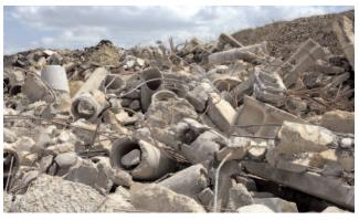
Pré-traitement de bétons de démolition avant leur recyclage.
