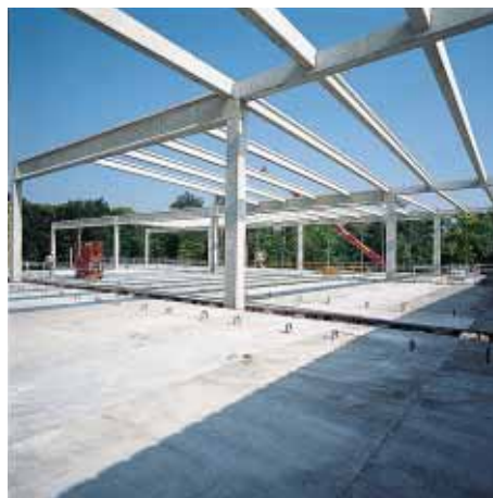
Centre de distribution Christian Dior à Saint-Jean-de-Braye.
