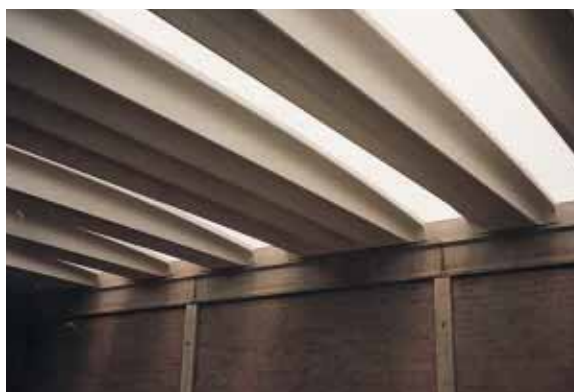
Couverture par coques en béton précontraint autoporteurs.
