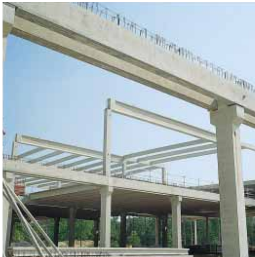
Centre de distribution Christian Dior à Saint-Jean-de-Braye.
