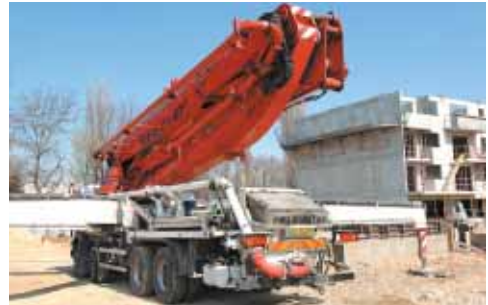
Pompe automotrice à flèche de répartition.
