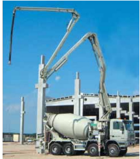
Camion malaxeur pompe.
