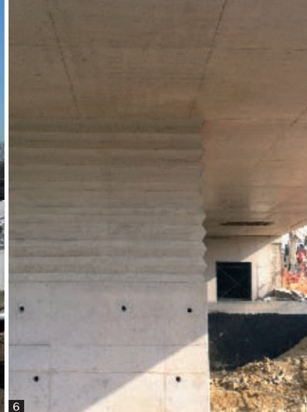
→ 5 et 6 • Un même ciment clair a été utilisé sur le chantier : (5) le bassin de pollution et de relèvement des effluents ; (6) les façades plissées du bâtiment de traitement membranaire.
