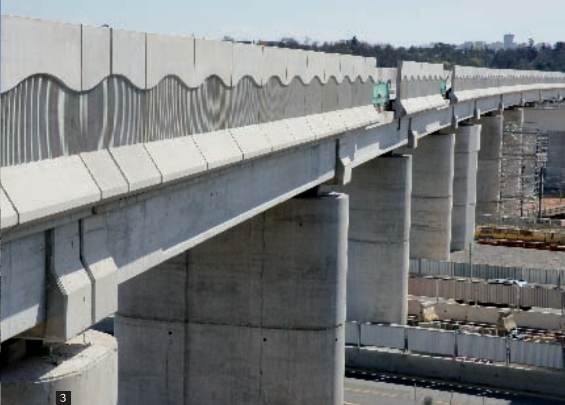
→ 3 • Le tablier est constitué de 476 poutres précontraintes par prétension (PRAD). 4 • La continuité des corniches-écrans en béton matérialise une vague.
