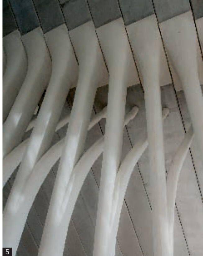
→ 4 et 5 • Les ergots que forment les jambes de force présentent un double intérêt : participer à l'exigence de robustesse des Eurocodes et parfaire l'élégance du dessin.
