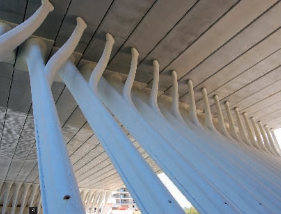
→ 4 et 5 • Les ergots que forment les jambes de force présentent un double intérêt : participer à l'exigence de robustesse des Eurocodes et parfaire l'élégance du dessin.
