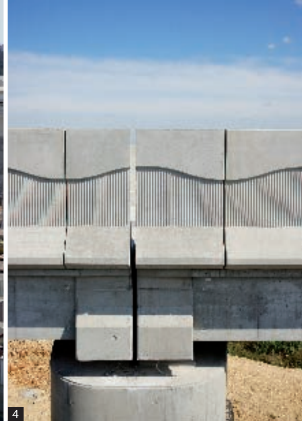
→ 3 • Le tablier est constitué de 476 poutres précontraintes par prétension (PRAD). 4 • La continuité des corniches-écrans en béton matérialise une vague.
