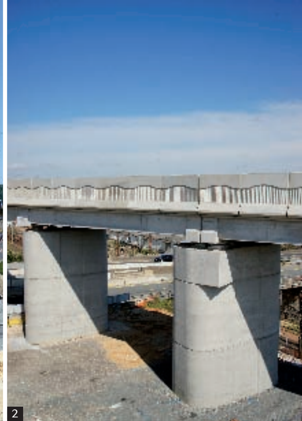
→ 1 • L'estacade de la Folie a dû s'intégrer dans un environnement complexe et dense. 2 • Trois mois environ étaient nécessaires pour construire une pile.
