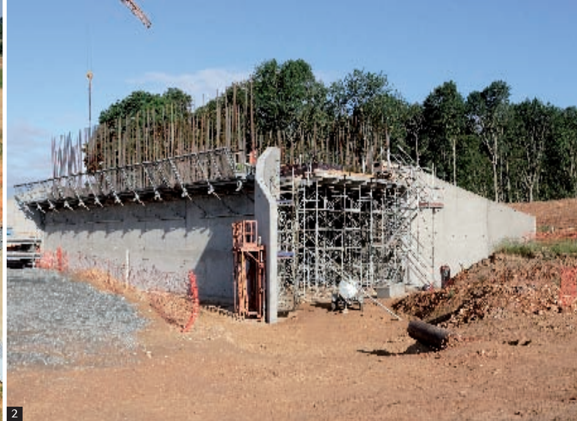
→ 1 • Les abords des passages « grande faune » sont aménagés sur des emprises de 1 hectare. 2 • Le passage inférieur de Mesnil-Panneville a été coulé en place.
