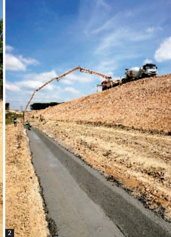
→ 1 • Double vocation pour cet ouvrage : voirie agricole et passage grande faune. 2 • Fossé en cours de bétonnage le long de la plate-forme ferroviaire.
