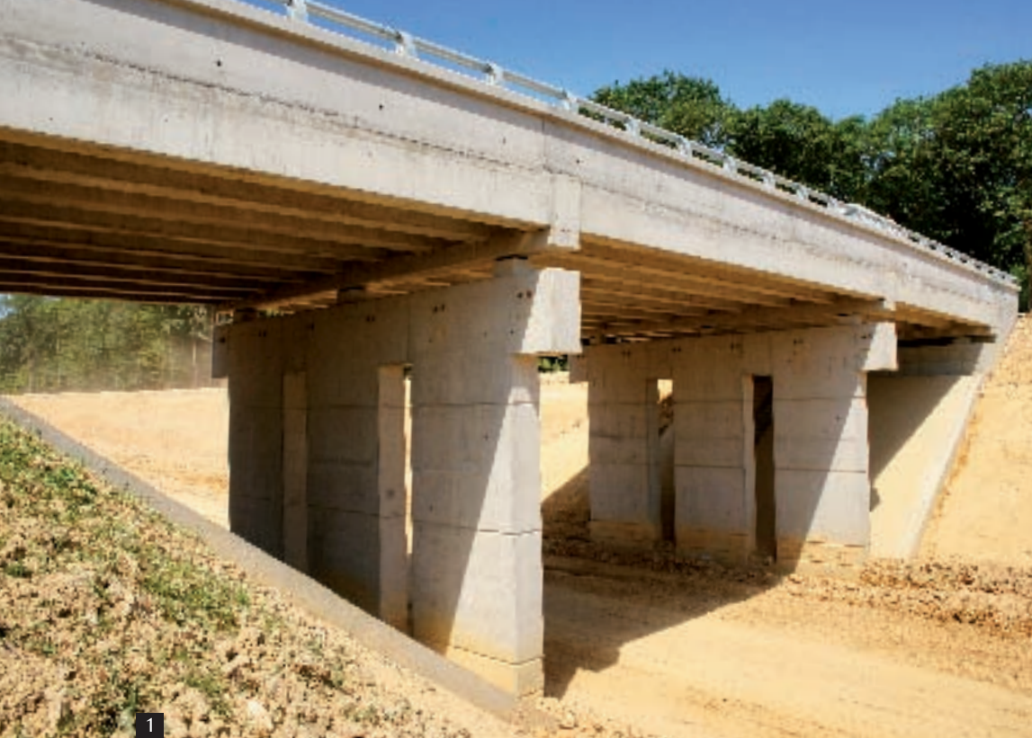
→ 1 • Double vocation pour cet ouvrage : voirie agricole et passage grande faune. 2 • Fossé en cours de bétonnage le long de la plate-forme ferroviaire.
