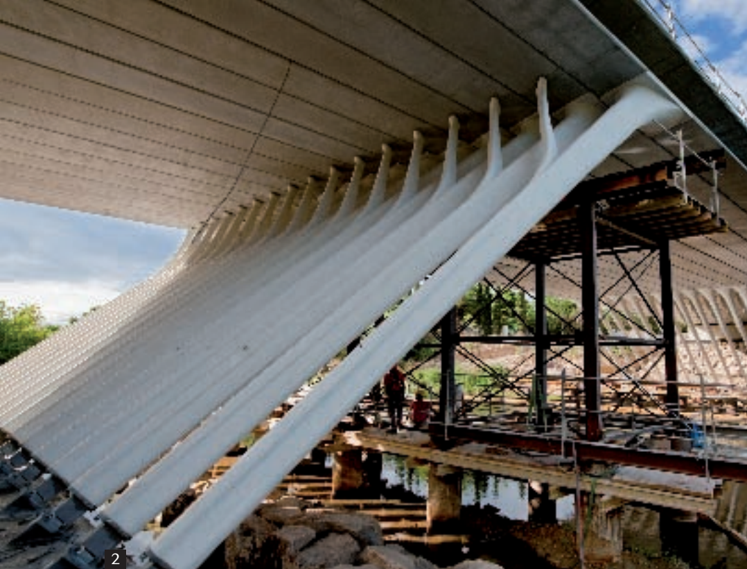
→ 2 • Poutres et béquilles sont précontraintes en usine par prétension. 3 • L'extrême finesse des béquilles en Ductal®.
