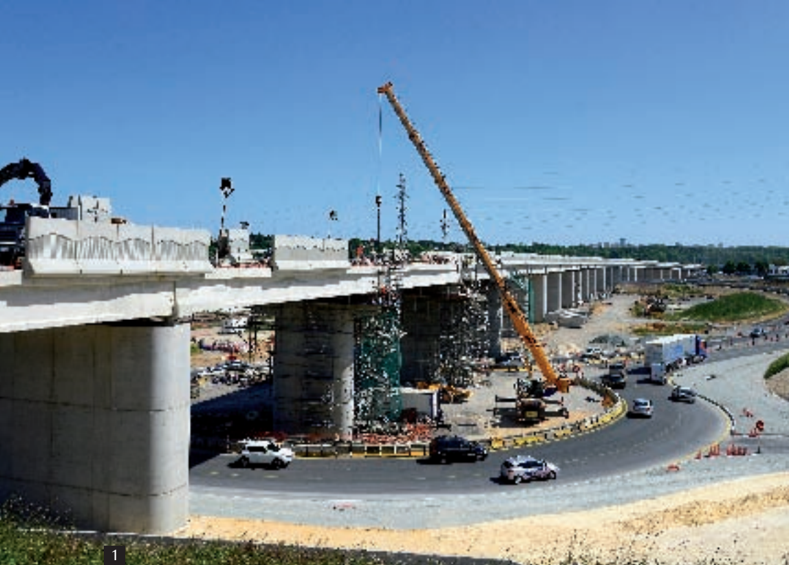
→ 1 • L'estacade de la Folie a dû s'intégrer dans un environnement complexe et dense. 2 • Trois mois environ étaient nécessaires pour construire une pile.
