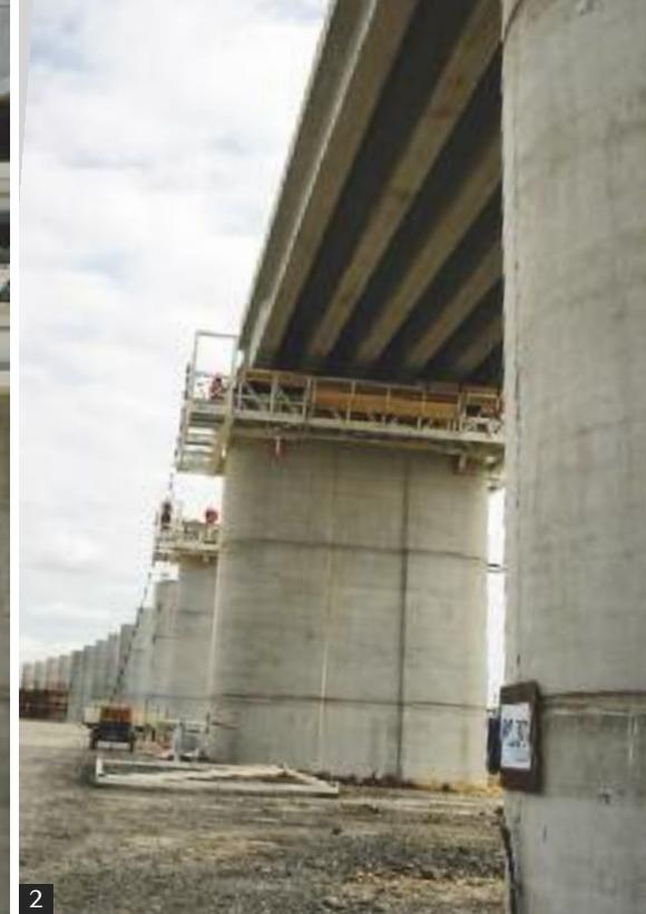
→ 1 et 2 • Estacade de La Folie au nord de Poitiers. Mise en place des poutres en béton précontraint.
