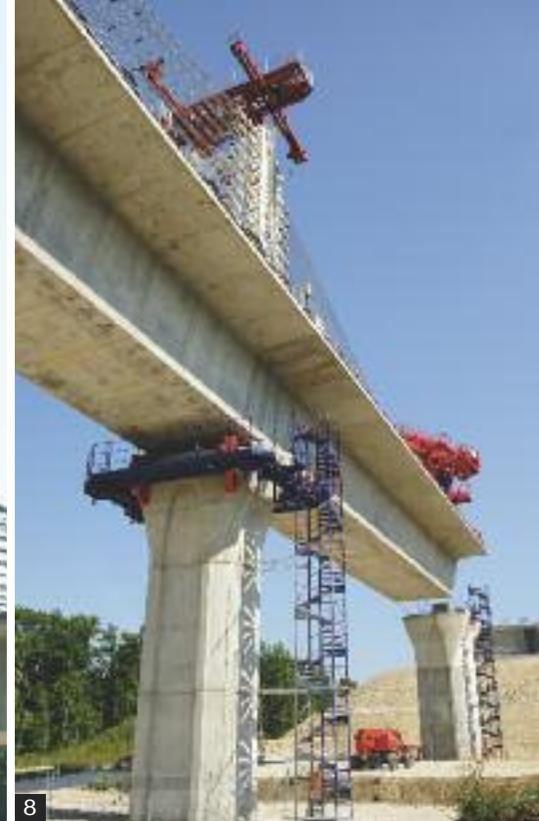
→ 7 et 8 • La pose des voussoirs préfabriqués, pesant entre 52 et 65 t, s'effectue à l'avancement par un système de haubannage provisoire.
