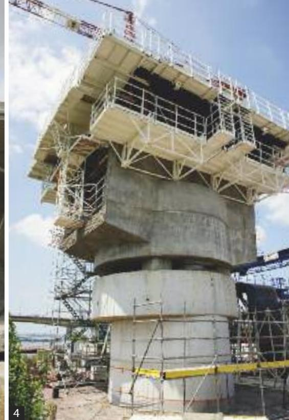
→ 3 • Une aire de préfabrication pour les 1 340 voussoirs a été créée à Coulombiers (Vienne). 4 • Le voussoir de 350 t sur la pile P8 du viaduc sur la Dordogne.
