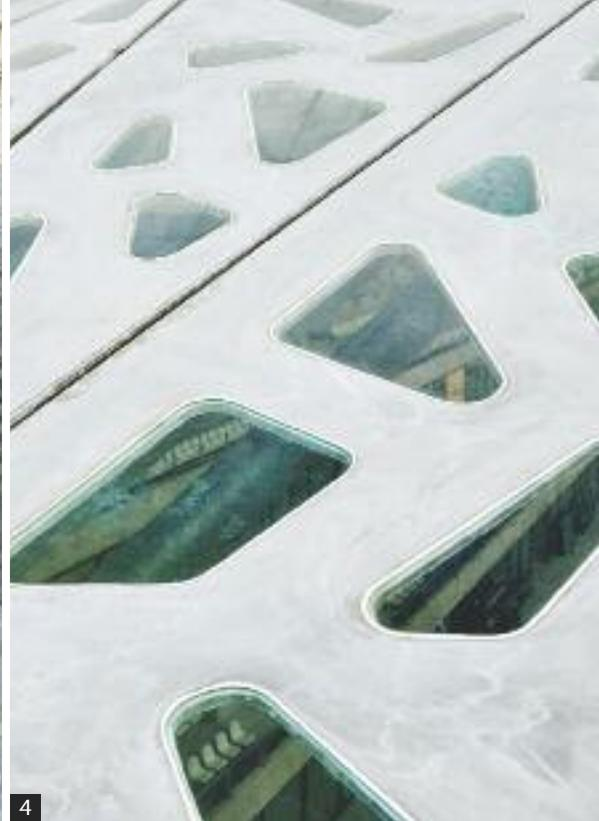
→ 3 et 4 • Pour les panneaux triangulaires de couverture, la combinaison verre/BFUP a fait l'objet d'un Atex.
