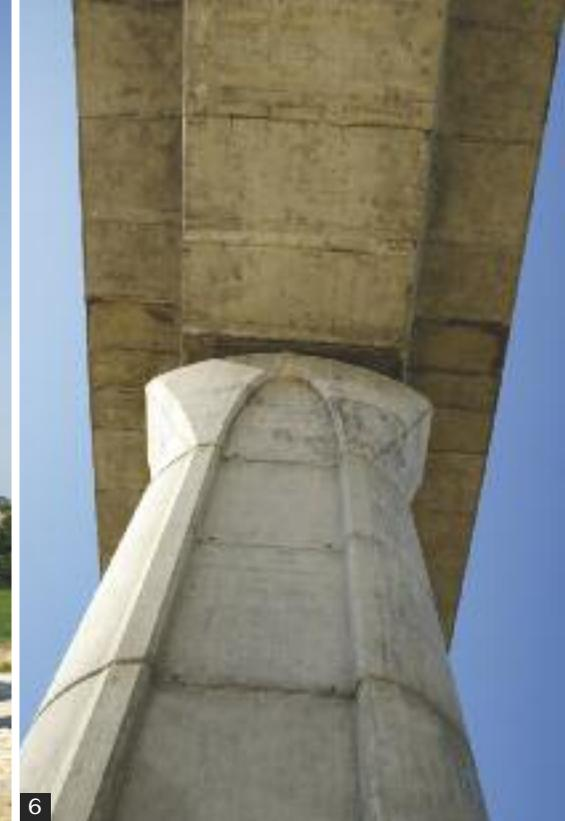
→ 5 • En juillet, le gros œuvre du viaduc de la Boème, long de 450 m, était déjà très avancé. 6 • Le tablier est constitué de voussoirs préfabriqués en béton précontraint.
