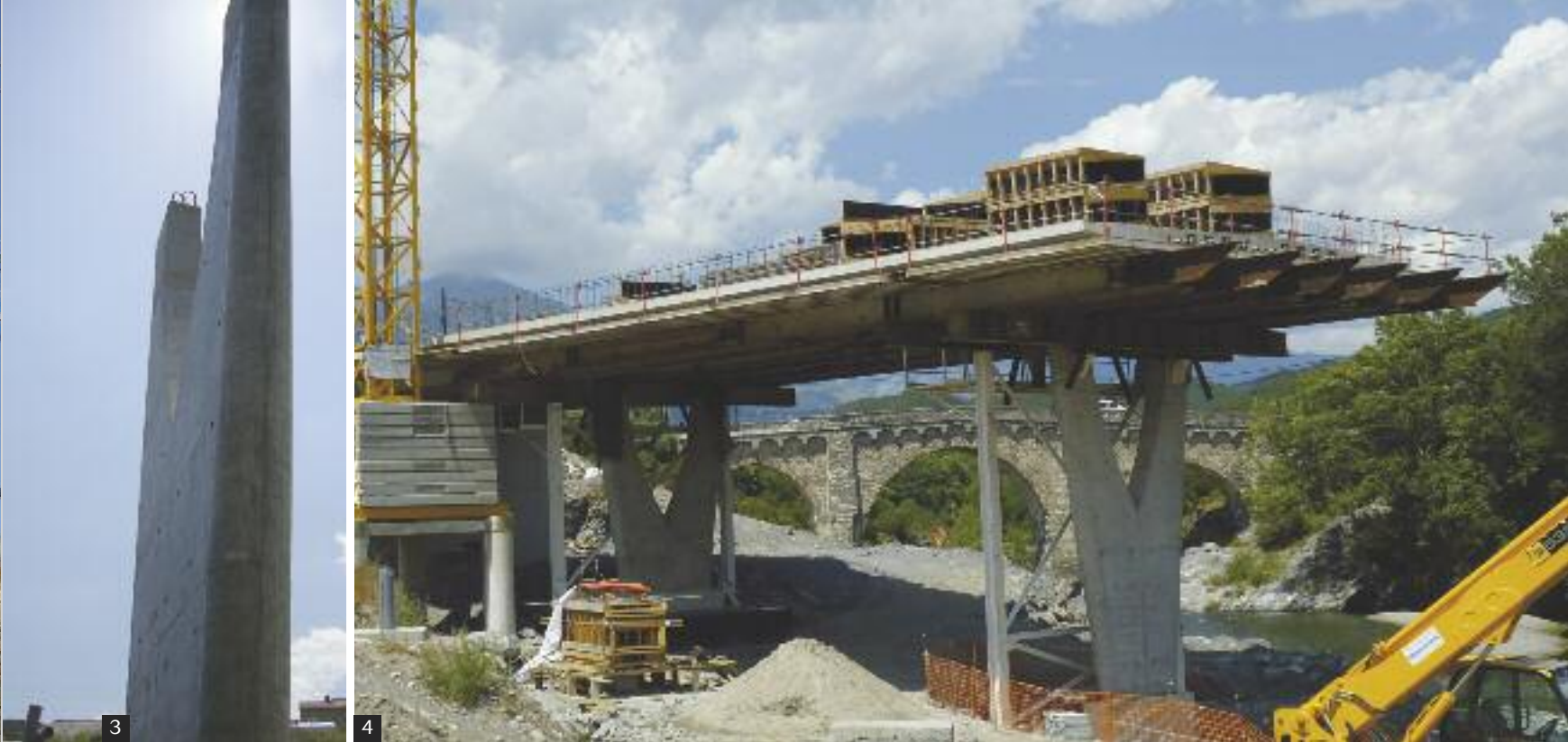
→ 3 • Les piles ne diffèrent que par leur longueur (6 m et 9 m). 4 • La finesse du tablier et les piles ajourées privilégient l'idée de transparence.
