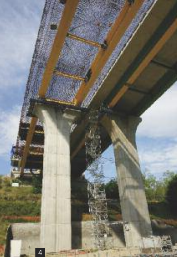
→ 4 et 5 • Chevêtres en forme de tulipe pour les six piles du viaduc du Buvet supportant deux tabliers indépendants pour chacun des sens de circulation.
