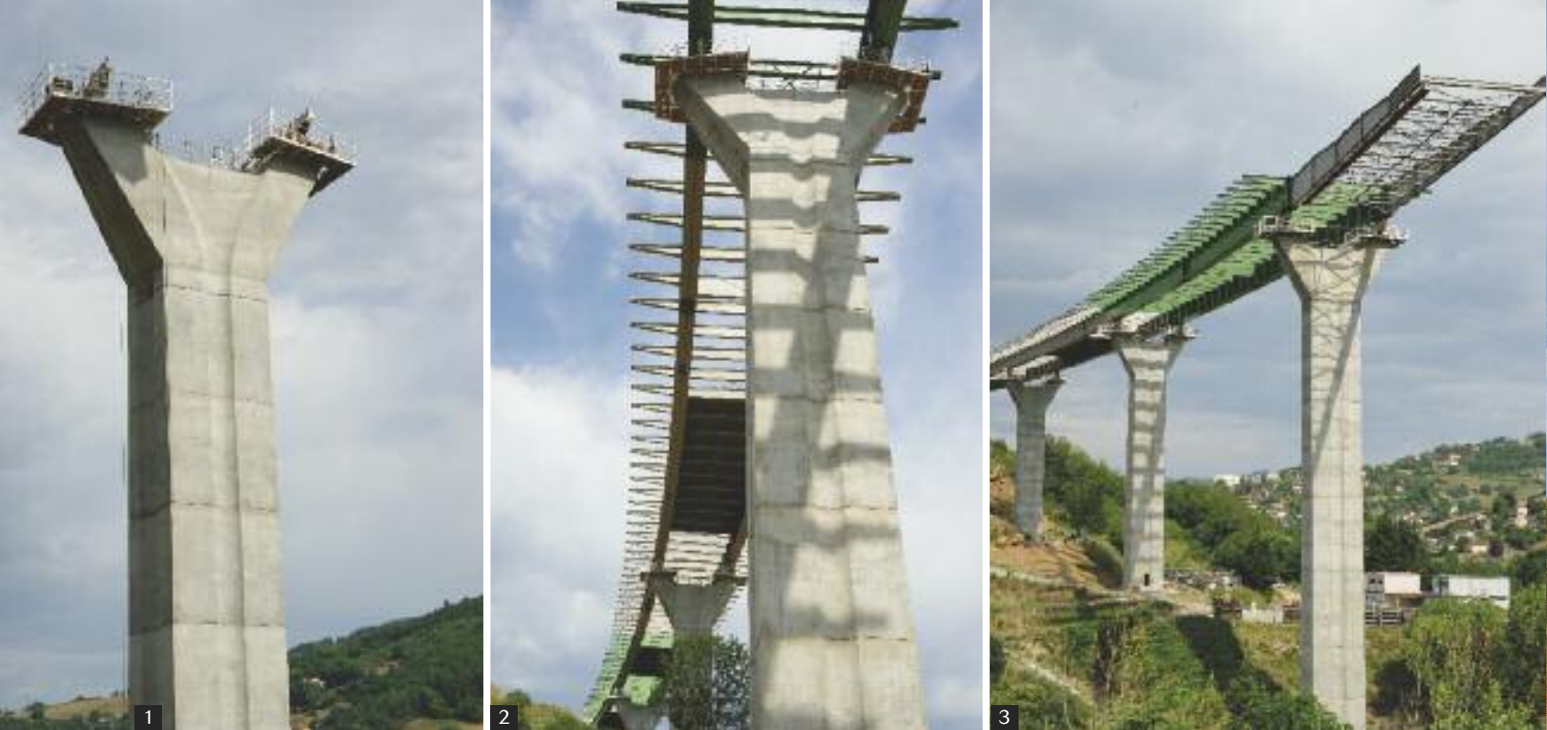
→ 1, 2 et 3 • Avec ses 622 m, le viaduc de Goutte Vignole est le plus long du projet, mais aussi le plus haut.
