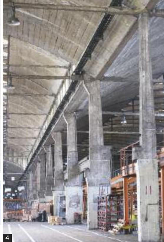
→ 3 et 4 • Finesse de la structure et des coques en béton. 5 • Les façades sont vitrées au maximum.
