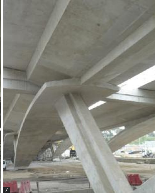
→ 6 et 7 • L'objectif architectural de la dentelle claire a nécessité un béton de résistance 65 MPa formulé avec un ciment blanc de l'usine du Teil.
