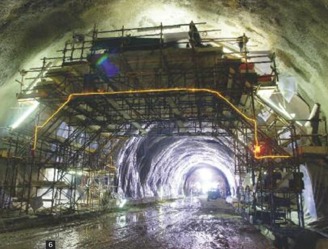
→ 6 et 7 • Tunnel de la Bussière. Sur le béton projeté, mise en place de l'étanchéité avant le revêtement définitif en béton. Les deux tubes sont reliés par deux rameaux.
