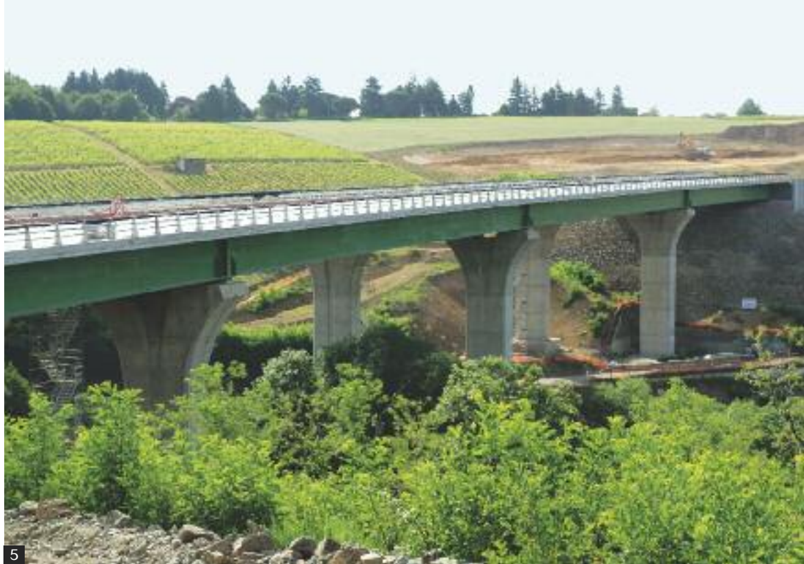
→ 4 et 5 • Chevêtres en forme de tulipe pour les six piles du viaduc du Buvet supportant deux tabliers indépendants pour chacun des sens de circulation.
