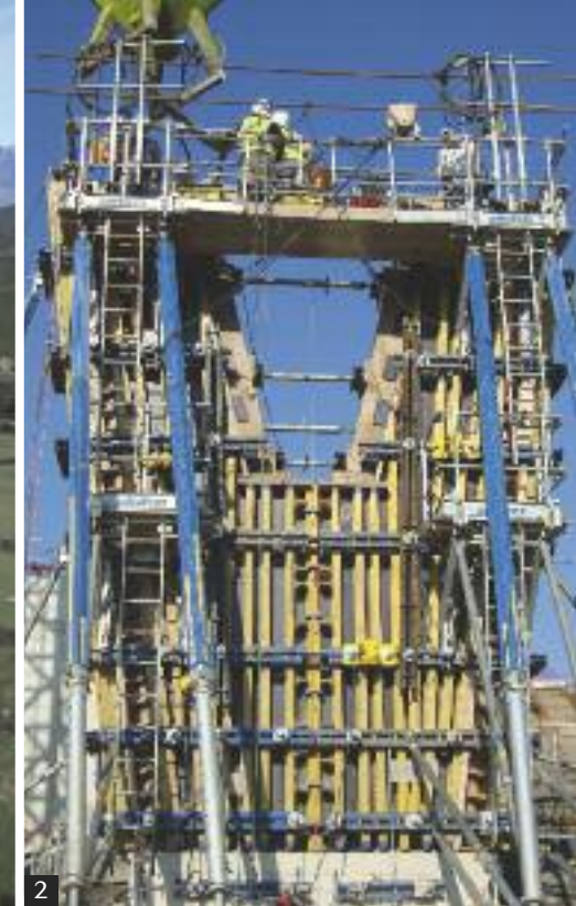
→ 1 • Le nouveau tracé laisse la part belle au pont génois et à la petite chapelle voisine, tous deux classés. 2 • Les piles en Y ont été réalisées avec des coffrages en bois.
