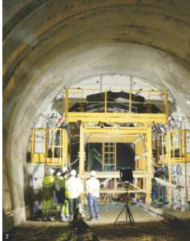
→ 6 et 7 • Tunnel de la Bussière. Sur le béton projeté, mise en place de l'étanchéité avant le revêtement définitif en béton. Les deux tubes sont reliés par deux rameaux.
