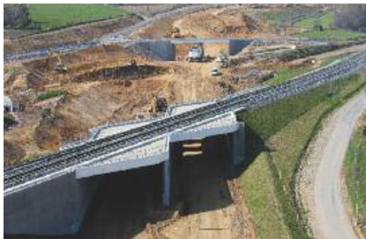
→ Sur la commune de Pontcharra-sur-Turdine, le pont-rail permettant le passage de l'A89 sous la ligne Lyon – Roanne.
