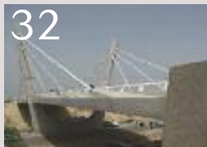
32 Pont sur l'autoroute Fès-Oujda Fès, Maroc
