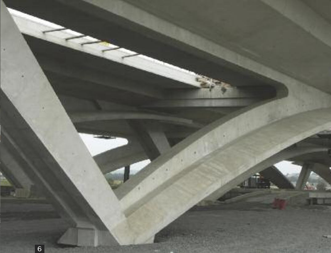
→ 6 et 7 • L'objectif architectural de la dentelle claire a nécessité un béton de résistance 65 MPa formulé avec un ciment blanc de l'usine du Teil.
