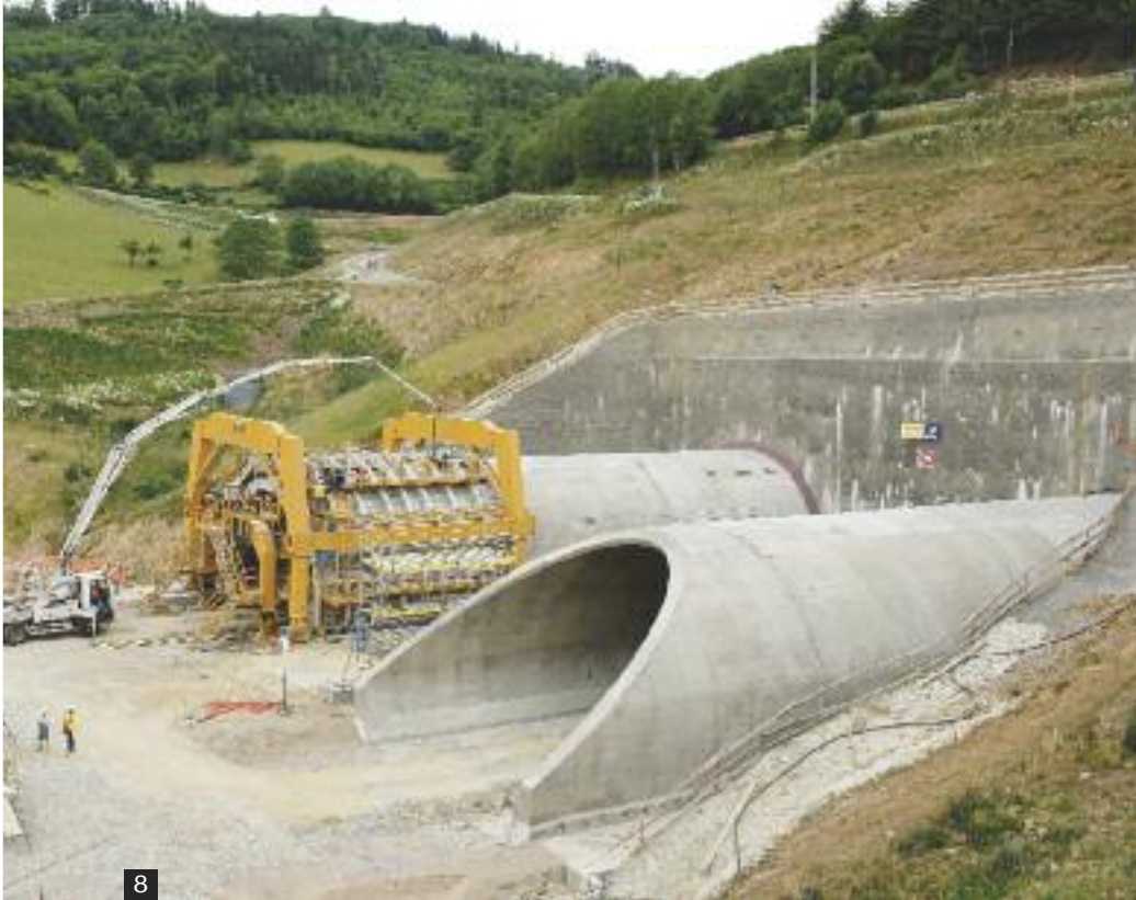
→ 8 • Les « casquettes » prolongeant les deux ouvrages de la Bussière. 9 • Éléments préfabriqués en béton pour les murs Terre Armée®.
