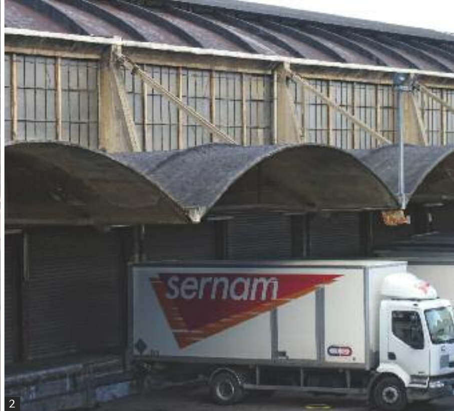
→ 1 et 2 • Les auvents extérieurs forment un unique voile ondulé directement inspiré des ondes plissées des hangars d'Orly.
