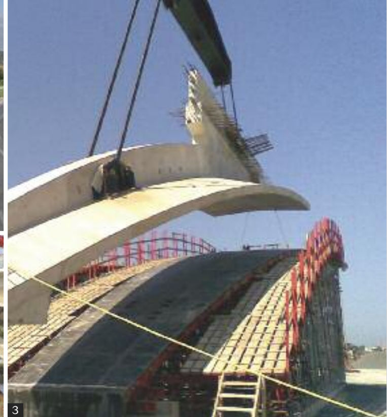
→ 1, 2 et 3 • Sur l'oued Bouregreg, le pont Hassan II se compose d'arcs évolutifs qui, partant de chacune des rives, convergent vers l'arc central.
