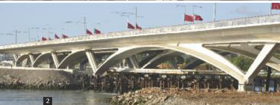
→ 1, 2 et 3 • Sur l'oued Bouregreg, le pont Hassan II se compose d'arcs évolutifs qui, partant de chacune des rives, convergent vers l'arc central.
