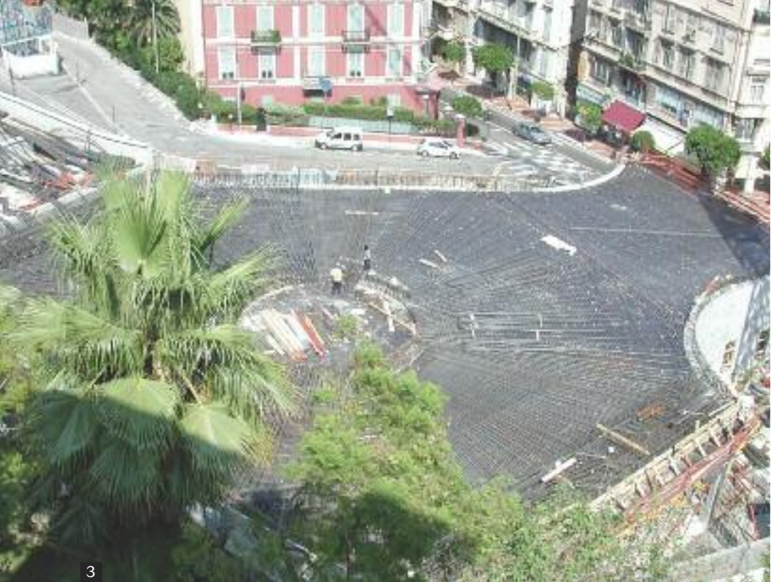
→ 3 • Le ferrailage du béton de la couverture du giratoire d'Aurégli est particulièrement dense. 4 • Imbrication du chantier au cœur même de la ville.
