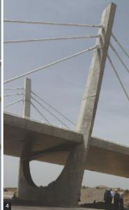
→ 1 • Le pylône axial adopte une forme en V. 2 • Vue de la culée 3 • Détail sur les haubans. 4 • Le tablier en béton précontraint vient s'encastrer dans le pylône.
