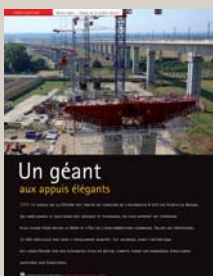
>> PAGE 26 > Rhône-Alpes Viaduc de la Côtière
