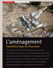
>> PAGE 11 > Corse Barrage du Rizzanese
