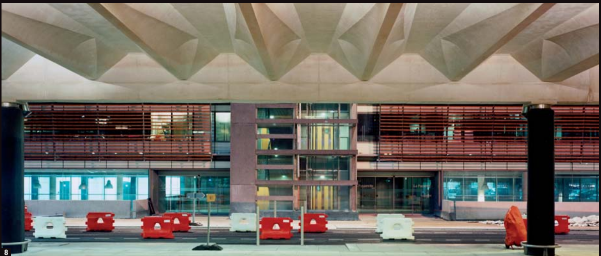
>>> Viaduc de Toulouse-Blagnac (France)
