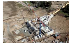
4 Le bassin de démodulation (15 000 m 3 ) à l'aval de la centrale hydro-électrique permet de restituer progressivement les débits turbinés dans le lit du fleuve.
