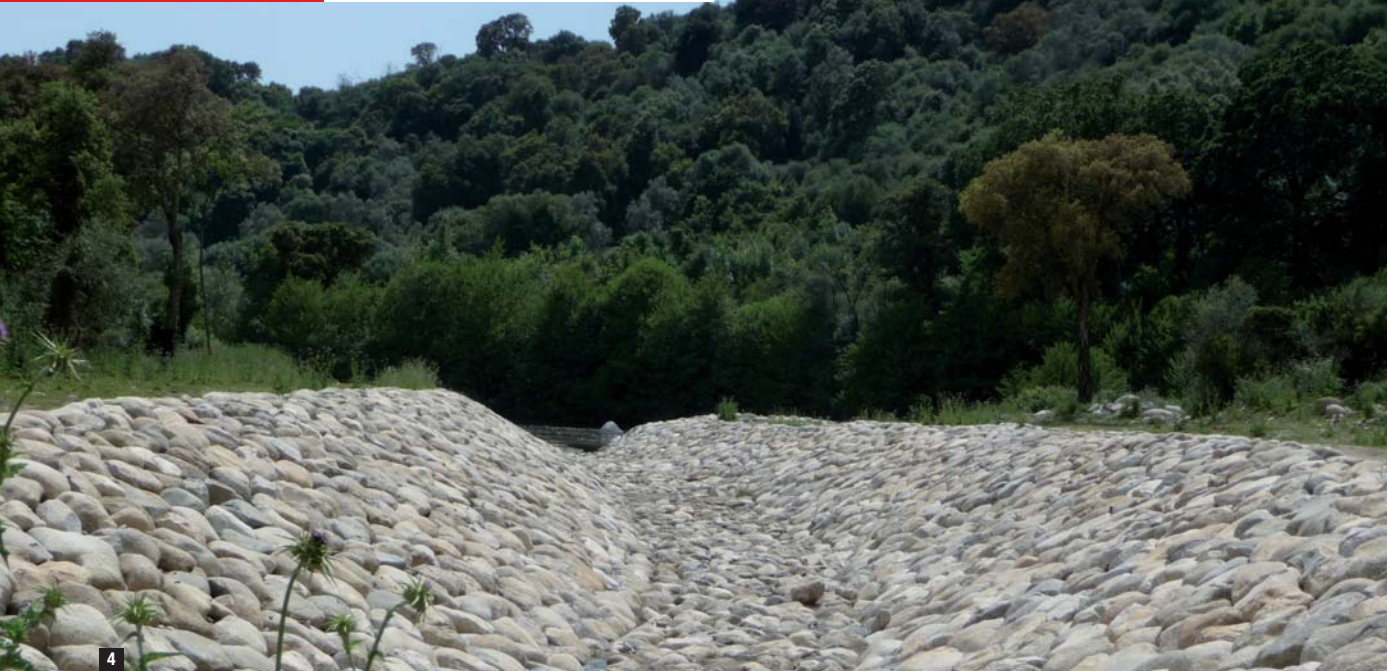
4 Le bassin de démodulation (15 000 m 3 ) à l'aval de la centrale hydro-électrique permet de restituer progressivement les débits turbinés dans le lit du fleuve.
