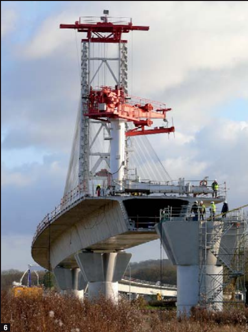
>>> Viaduc de Compiègne (France).
