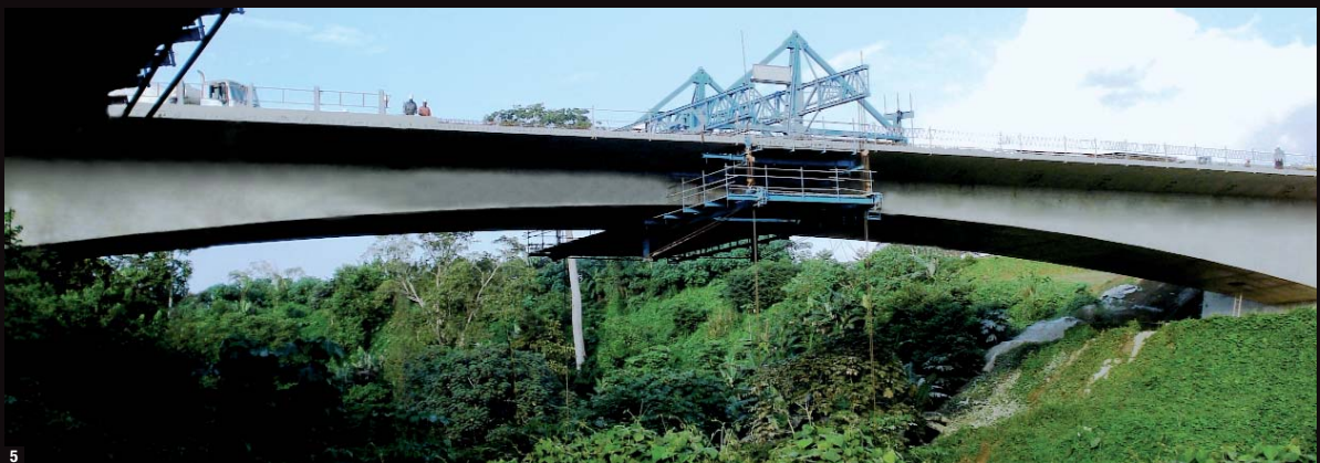
>>> Pont sur le Rio Timbabe (Guinée Equatoriale).
