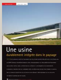
>> PAGE 30 > Achères – Usine de traitement des eaux usées
