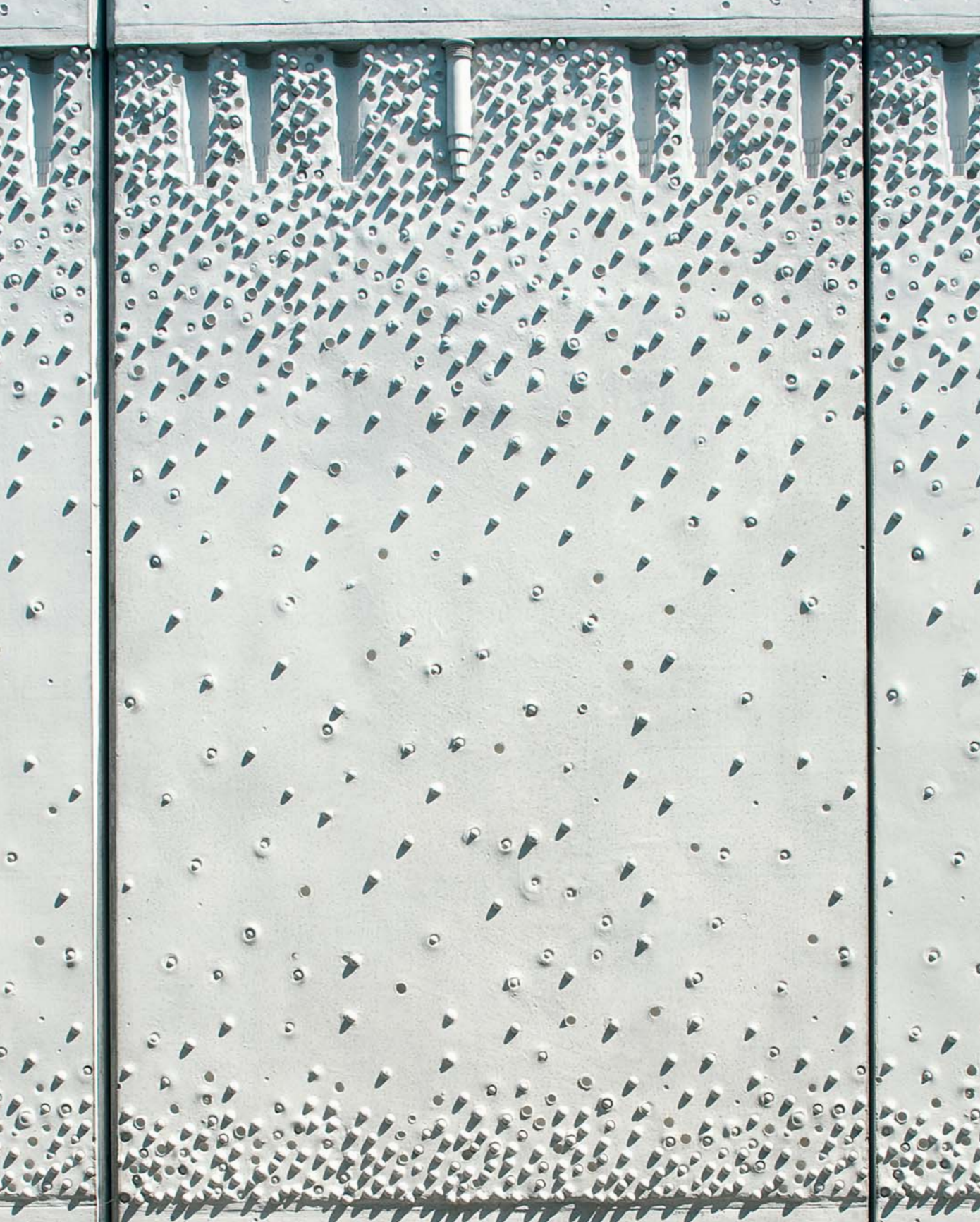
Panneaux préfabriqués en béton matricé sur le site du SIAAP, société d'architecture Luc Weizmann.
