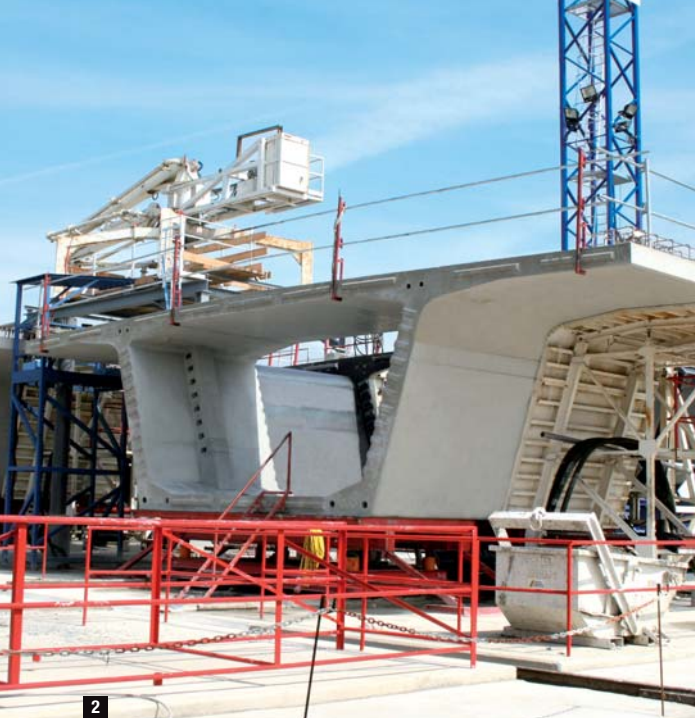
>>> 2 Cellules de bétonnage, avec voussoir placé en contre-moule. 3 Une partie du stock de voussoirs, vue depuis la grue du chantier. Le stockage sur deux niveaux permet un gain de place.
