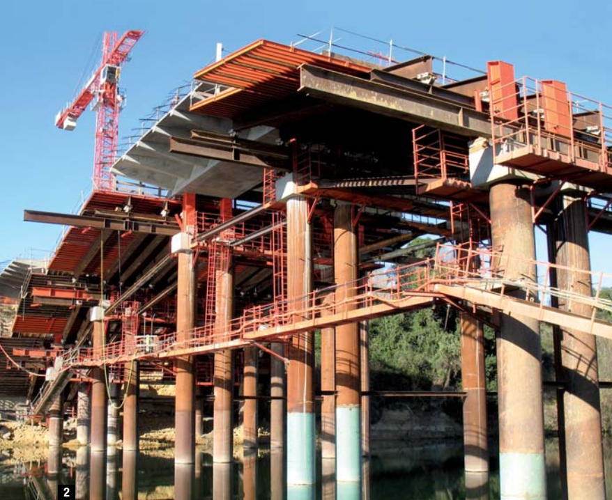
➤➤➤ 1 Des appareils d'appuis spécialement étudiés servent à la base des béquilles rive gauche pour la reprise d'effort entre 2 000 et 3 000 t. Au fond, vue sur l'ancien pont de Gignac en pierre, inscrit à l'inventaire supplémentaire des monuments historiques. 2 La réalisation de l'ouvrage a nécessité la construction d'un pont provisoire armé à 11 palées, situées pour la plupart dans le lit de l'Hérault. 3 Phase de bétonnage du tablier.
