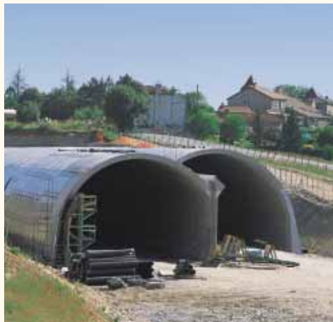
TRANCHÉE DE LA GARENNE – CAHORS – A 20
