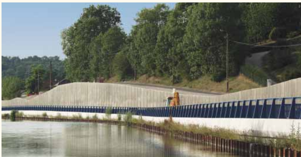
MUR DE SOUTÈNEMENT – BAR-LE-DUC
