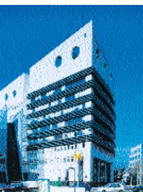
>>> En couverture : Cap Ampère, le centre EDF de Saint-Denis.
