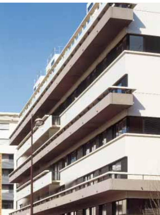
▲ Sur les deux opérations, les façades sont équipées de balcons filants en béton, constitués d'une allège et d'un appui décollés par des platines métalliques peintes en noir. Les deux éléments sont boulonnés à Duplex, et scellés à Bercy.
