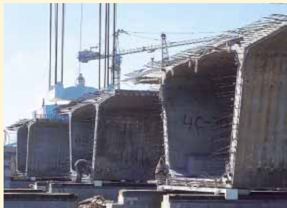
▲ La préfabrication a été généralement privilégiée pour la construction des tabliers, faisant ainsi bénéficier l'organisation des travaux de sa souplesse intrinsèque.
