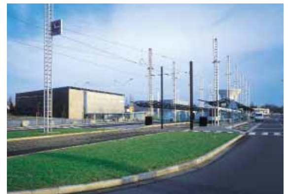
▲ Le volume du parking est marqué par des parois en panneaux de béton préfabriqués revêtus d'une lasure vert sombre.
