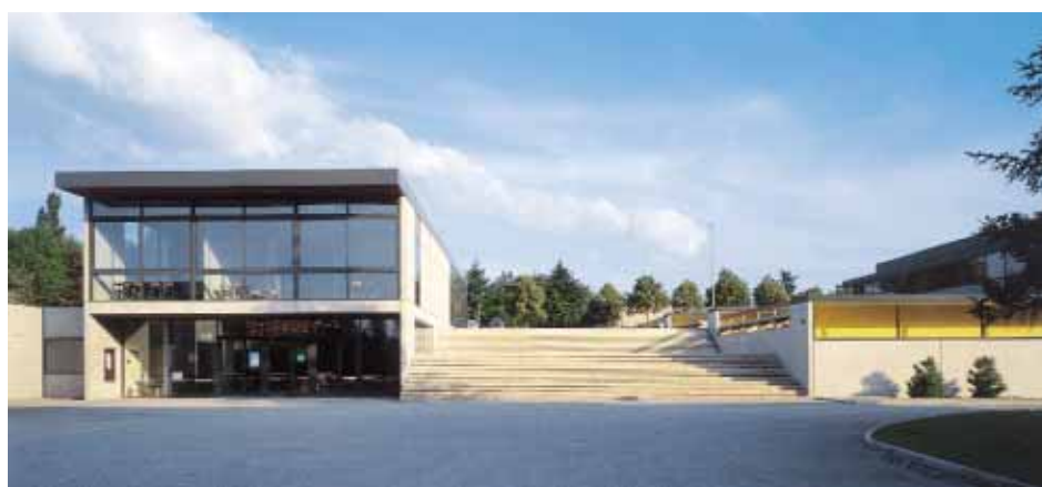
▲ Les façades alternent les parois en béton brut ou sablé et les plans vitrés transparents.
