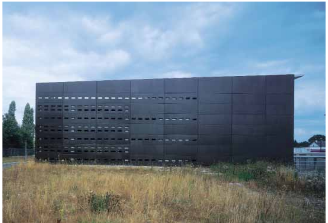
▲ Le volume du parking est marqué par des parois en panneaux de béton préfabriqués revêtus d'une lasure vert sombre.
