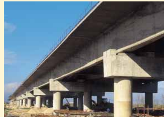
▲ Le viaduc sud, solidement établi sur quatre piles et un chevêtre d'appui, élance ses 3,8 kilomètres au-dessus des marais salants.
