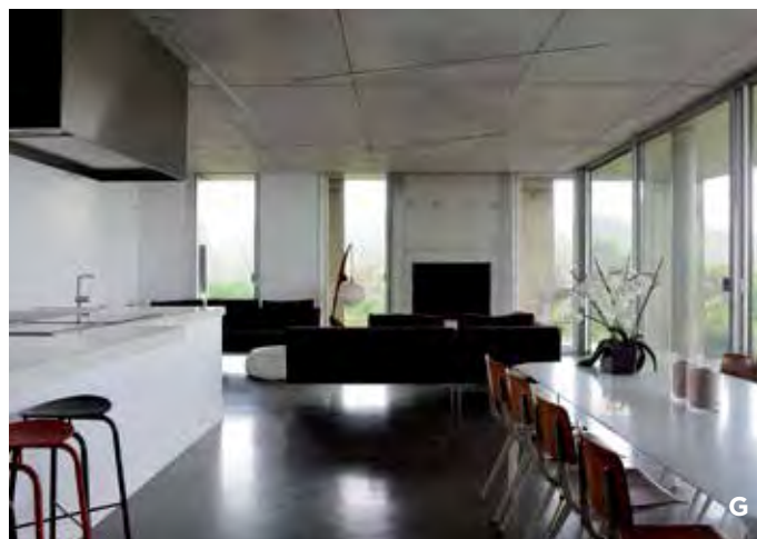
G ____ Un béton omniprésent, brut pour la structure, la sous-face des plafonds et certains parois.
