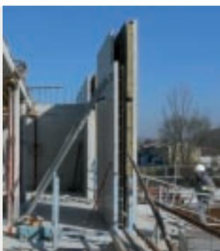
← Le système constructif retenu pour l'ensemble de l'enveloppe extérieure de ce projet est composé de murs à coffrage intégré avec isolation, fabriqués en usine. Deux peaux de béton sont reliées et fixées entre elles par des connecteurs. Une couche d'isolant est posée sur la face interne de la paroi extérieure, ce qui permet d'atteindre d'excellentes performances énergétiques (BBC RT 2012).
