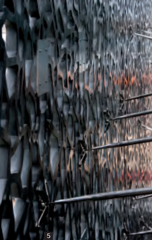
→ 5 • Les panneaux de façade sont tenus par des bracons. 6 • La résille de la toiture est portée par des potences en BFUP, auxquelles sont aussi suspendues les coursives périphériques.
