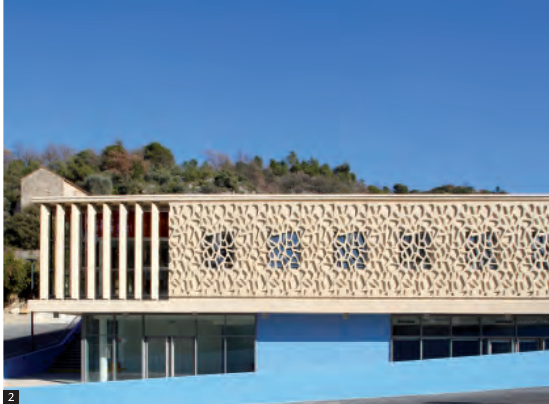
→ 1 • En amont, le projet avec sa toiture plantée s'insère en toute harmonie dans le site. 2 • Au sud, les baies sont protégées du soleil par des lames ou des résilles de béton.
