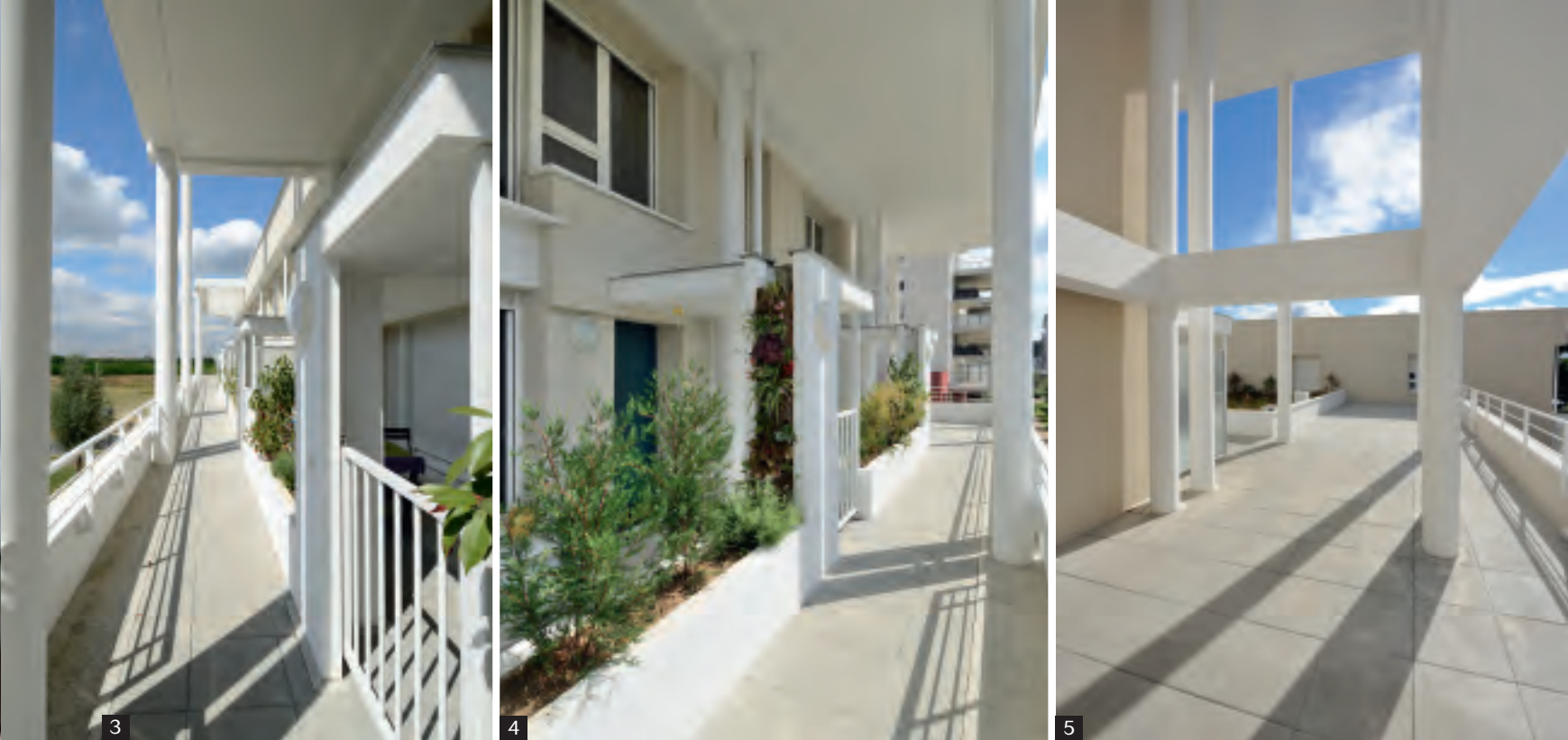
→ 3 et 4 • Vues sur les coursives, les entrées de logements et les terrasses/jardins devant les séjours. 5 • En sortant de l'ascenseur au premier étage.
