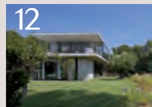
12 Maison – Grimaud (83) Architecte : Raphaëlle Segond
