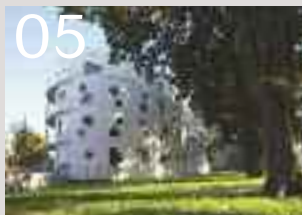
05 Maison d'enfants – Mulhouse (68) – Architecte : Hugues Klein Architects
