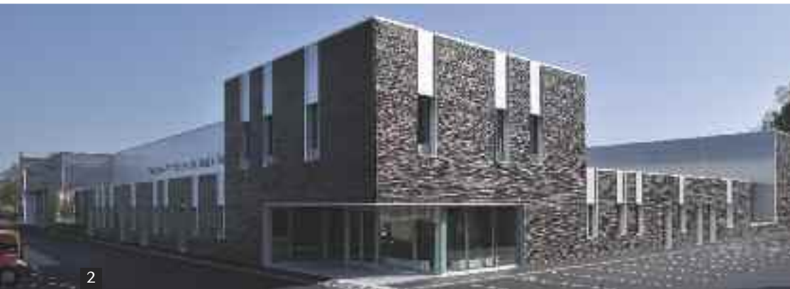
→ 1 • Des façades porteuses en béton matricé lasuré. 2 • De grands volumes en polycarbonate. 3 • Des ouvertures définies par des empochements en verre.
