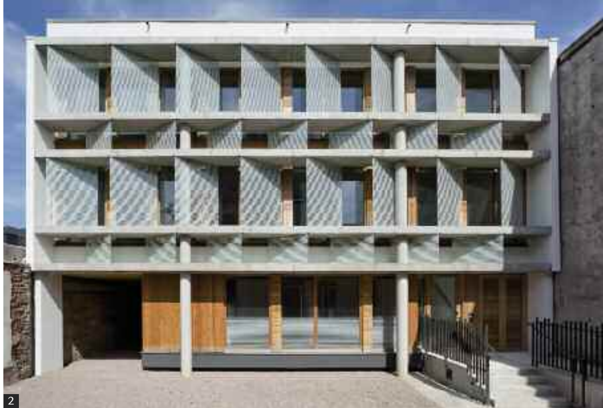
→ 1 • Un retrait en creux signale l'entrée. 2 • Brise-soleil de la façade sud-ouest du deuxième bâtiment.
