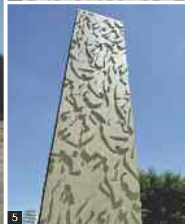
→ 1 • Vue depuis le parc Kennedy. 2 • Vue depuis l'amphithéâtre de verdure. 3 • Détail de la façade sud. 4 • Vue de détail du motif. 5 • Lé de la matrice élastomère.
