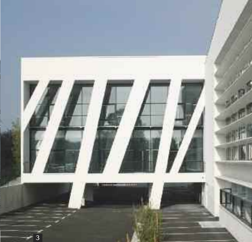
→ 3 • Les façades sud et ouest disposent chacune de pare-soleil en béton. 4 • Les redents orientés au nord offre aux salles de lecture une lumière naturelle sans ensoleillement direct.
