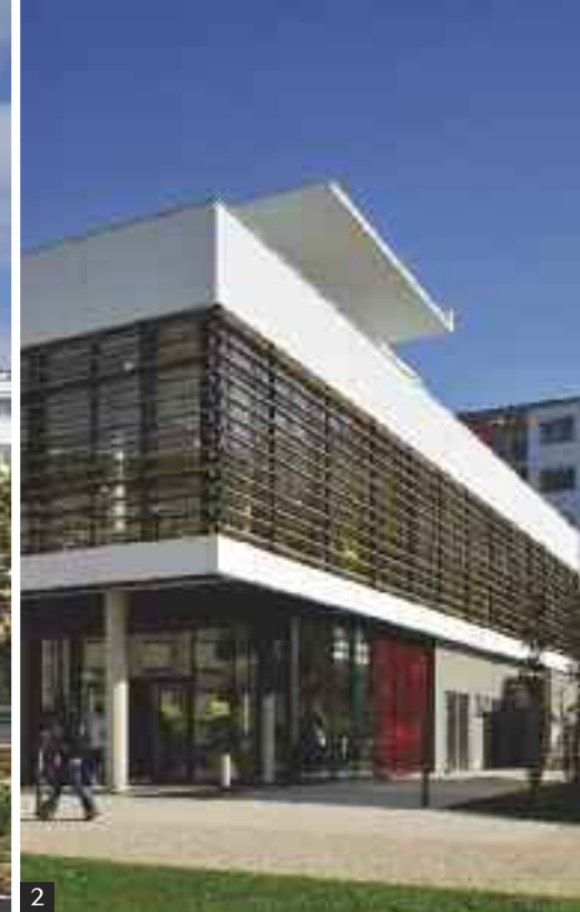
→ 1 • Le bâtiment, paré de béton blanc, se détache avec subtilité de son environnement. 2 • L'entrée principale est naturellement protégée par le débord de dalle.
