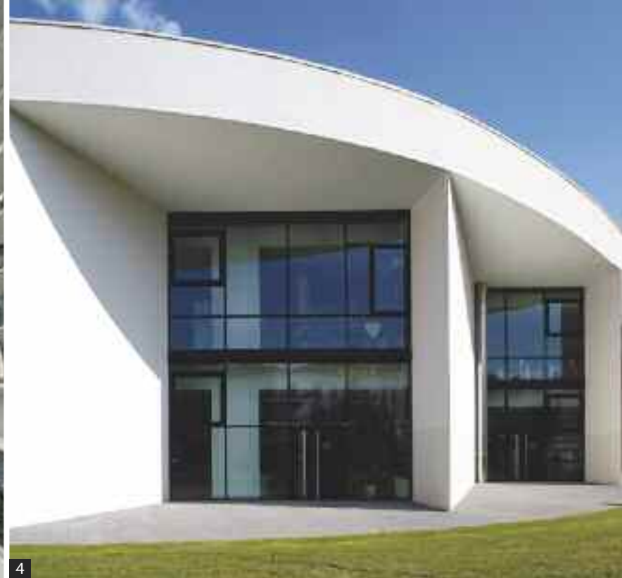
→ 3 • Les façades sud et ouest disposent chacune de pare-soleil en béton. 4 • Les redents orientés au nord offre aux salles de lecture une lumière naturelle sans ensoleillement direct.
