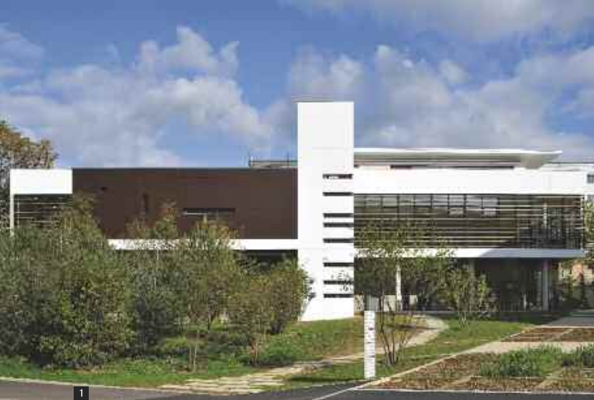
→ 1 • Le bâtiment, paré de béton blanc, se détache avec subtilité de son environnement. 2 • L'entrée principale est naturellement protégée par le débord de dalle.
