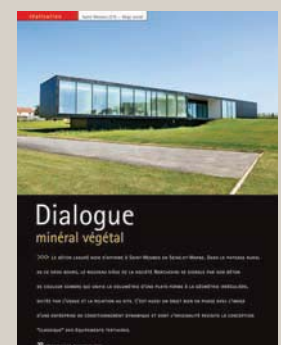
>> PAGE 32 > Saint-Mesmes Siège social Architecte : LAN Architecture
