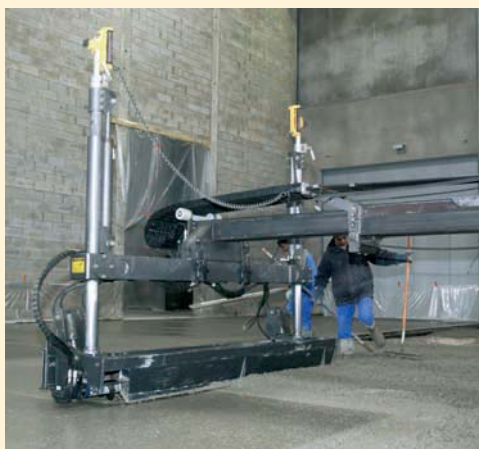
>>> Dressage automatique du béton.
