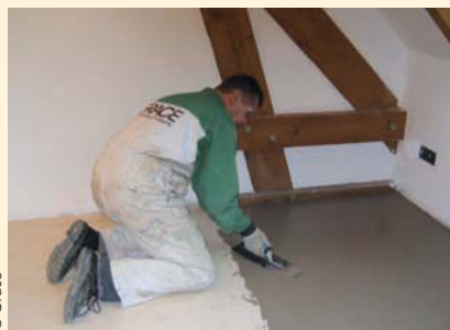
>>> Lissage manuel millimétrique.
