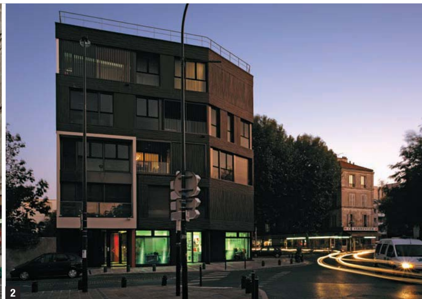
>>> 1 De facture contemporaine, le volume reprend le gabarit traditionnel des immeubles voisins et conforte la place Parmentier dans son échelle domestique. 2 Monolithique, l'immeuble est traité comme un prisme aux multiples facettes dont la teinte monochrome et les effets de matière renvoient aux tableaux de Pierre Soulages.
