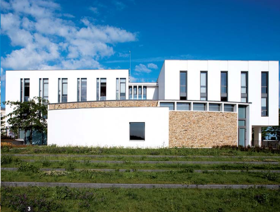
3 La salle du conseil et la salle des mariages sont organisées dans un espace en forme de coquillage glissé sous l'édifice principal. 4 Construites avec des panneaux préfabriqués en béton, servant de coffrage perdu, les élévations sont rythmées par de grands percements verticaux.
