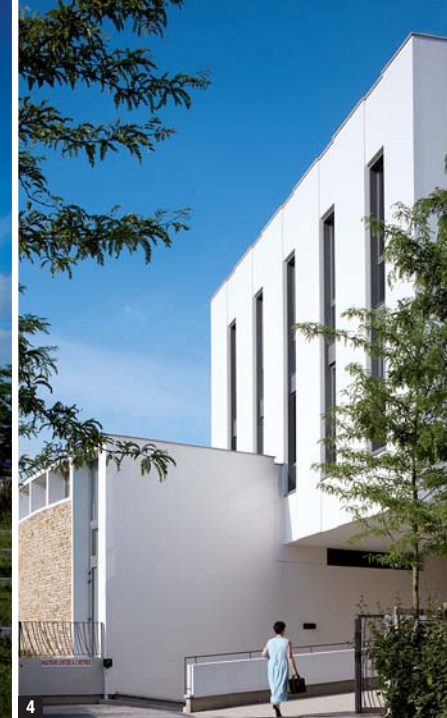
3 La salle du conseil et la salle des mariages sont organisées dans un espace en forme de coquillage glissé sous l'édifice principal. 4 Construites avec des panneaux préfabriqués en béton, servant de coffrage perdu, les élévations sont rythmées par de grands percements verticaux.
