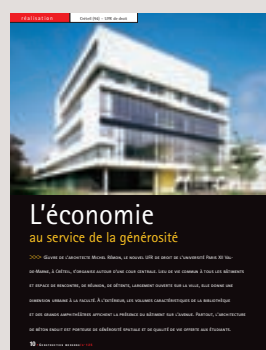
>> PAGE 10 > Créteil – UFR de droit – Architecte : Michel Rémon
