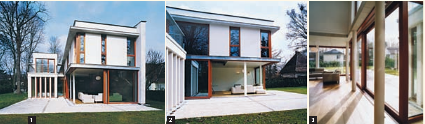
>>> 1 et 2 Au sud et à l'ouest, des baies vitrées coulissantes aux dimensions généreuses (2,70 x 2,70 m) laissent pénétrer une abondante lumière naturelle qui contribue à réchauffer les espaces à vivre. 3 Des poteaux de béton reprennent les charges au niveau des façades vitrées.
