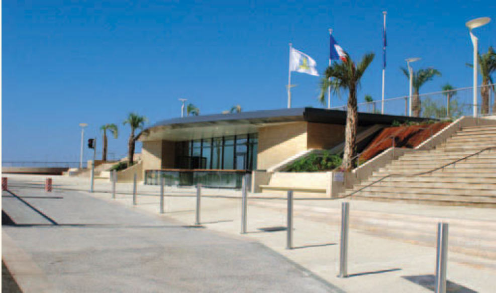
PARKING À SAINT-RAPHAËL (83)
