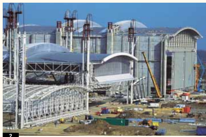
>>> Du Centre Pompidou à Paris (1) au chantier de l'usine de montage de l'Airbus A380 à Toulouse-Blagnac (2), le béton donne corps à des murs coupe-feu aux dimensions exceptionnelles.
