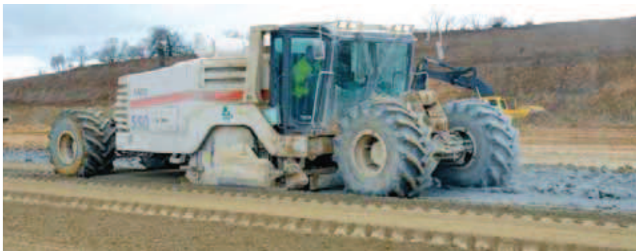
Le malaxeur utilisé pour le traitement en place à la chaux et au liant hydraulique routier.
