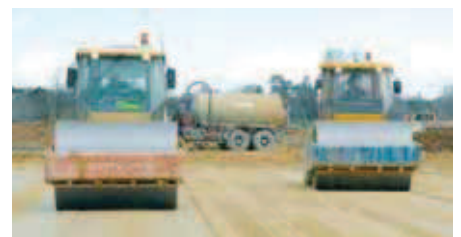
L'indispensable compactage final.
