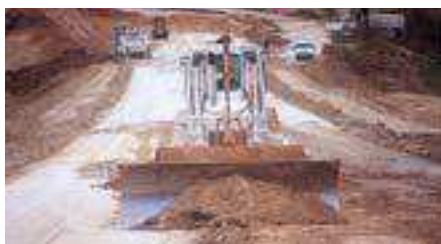
La niveleuse, contrôlée par GPS, règle l'arase de terrassement et la couche de forme.
