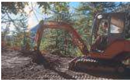
La pelle mécanique permet d'homogénéiser les agrégats et de niveler le terrain.
