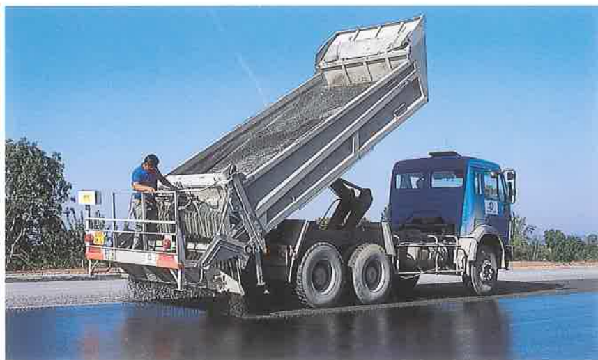
▲ Enduit de cure : émulsion et gravillons.
