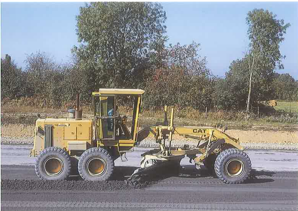
▲ La niveuse règle l'altimétrie de la couche.
