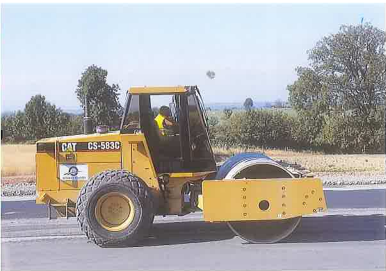
▲ Le sable traité est compacté avec des compacteurs vibrants et des compacteurs à pneus.
