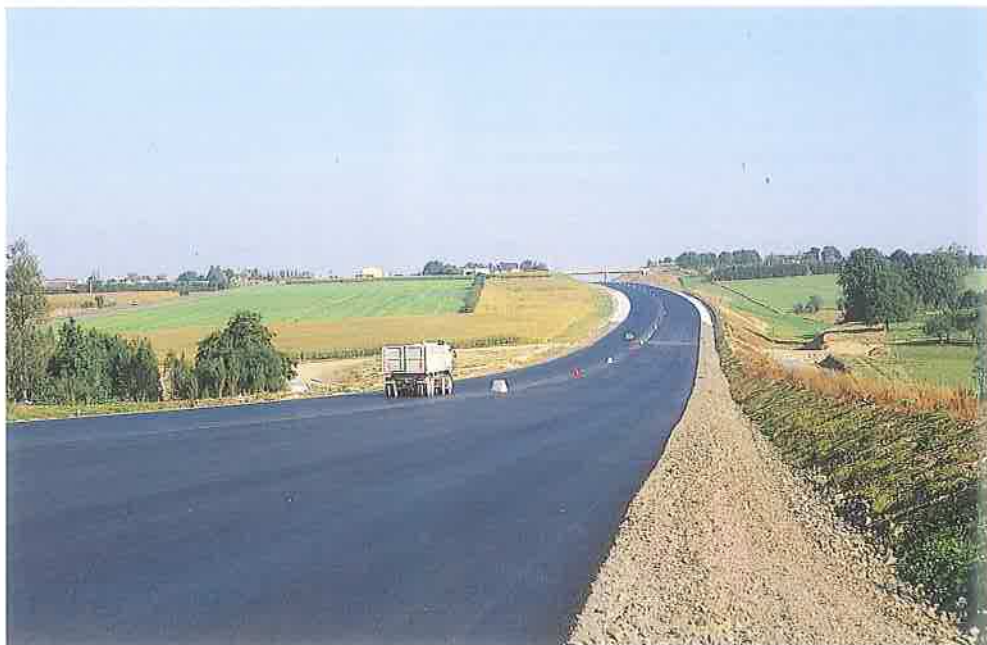
▲ À chantier d'exception, moyens d'exception. La réalisation de ce tronçon de l'A84 dans le Calvados fait appel à des techniques pointues et peu coûteuses, mises en œuvre dans des délais records.
