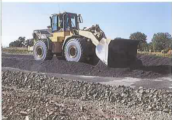
▲ Une chargeuse assure un prééplage du matériau.
