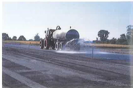
▲ L'arrosage de la couche de sable traité permet de compenser l'évaporation et ainsi de protéger la structure de la dessiccation.
