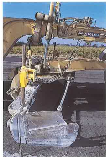
▲ La niveuse est équipée d'un système de guidage par ultrasons qui fournit à partir d'un câble tendu une référence de hauteur avec une précision inférieure à 5 mm.
