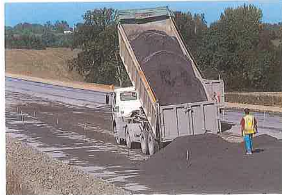
▲ Des camions-bennes déversent le sable traité sur le fond de forme.
