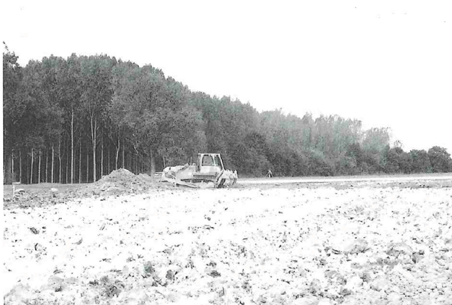
▲ Traitement par couches successives de 35 cm ...
