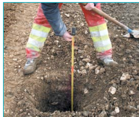
Un carottage permet de vérifier que la profondeur du traitement (40 cm) est bien conforme à ce qui était prévu.
