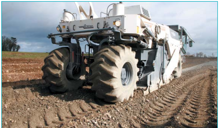
Phase de malaxage des matériaux mis à nu par les terrassements.
