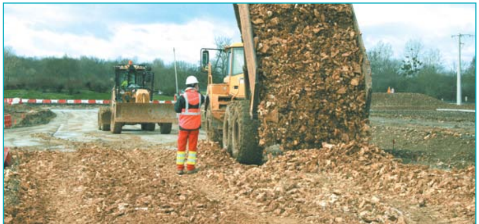
Déversement en surface des matériaux mis à nu par les terrassements.
