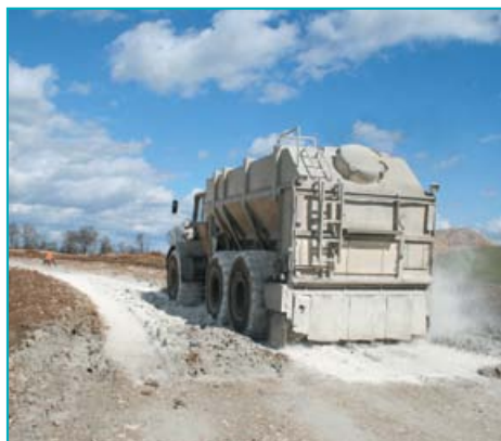
À gauche : épandage de la chaux, dosée à 1%. À droite : épandage du liant hydraulique routier, dosé à 7%.
