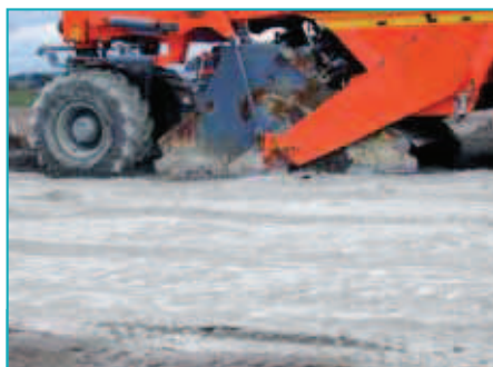
Le malaxage du sol intervient sur 45 cm de profondeur.
