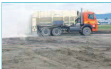
L'épandage du liant hydraulique routier est réalisé à raison de 35 kg/m 2 .
