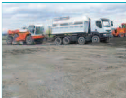
L'hydratation par camion porte-citerne est immédiatement suivie du passage du malaxeur.
