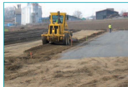
Le nivelage précède le passage du compacteur à roues.
