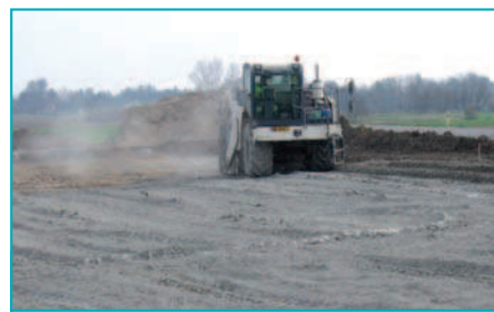
Le passage du rotomalaxeur mélange, de façon homogène, le sol et le liant hydraulique routier.
