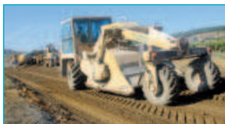
Le pulvimixeur mélange limon, ciment et eau pour créer la couche de forme.
