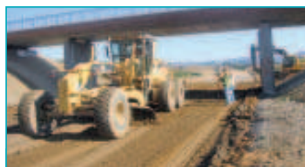
La niveleuse règle la couche de limon sur 35 centimètres d'épaisseur.
