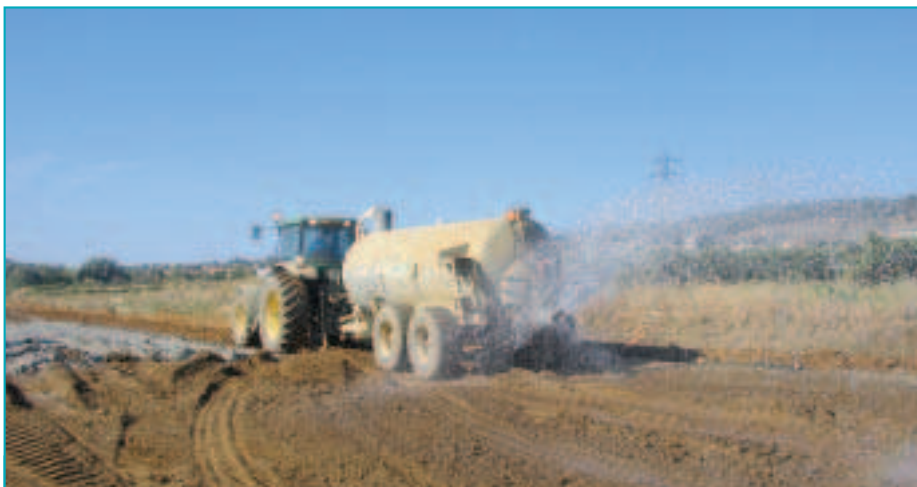
L'arrosage du limon permet l'hydratation du ciment et assure la prise du mélange.
