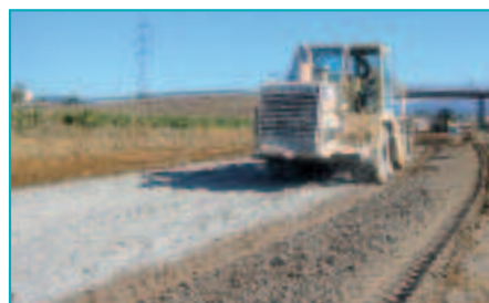
Epandage d'un ciment CEM II 32,5 CE NF, dosé à 5 % en moyenne.
