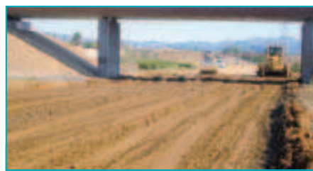
Compactage de la couche de forme.
