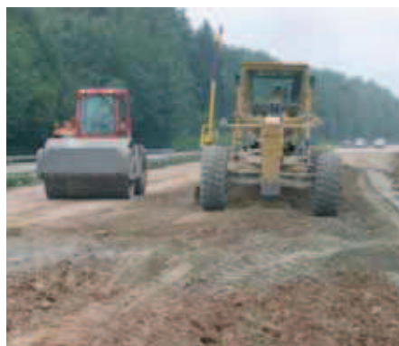
Réglage et compactage de la couche de forme traitée au ciment.
