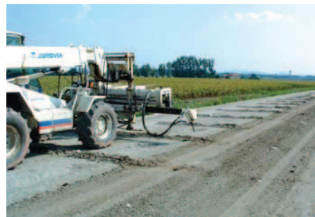
Préfissuration sur toute la largeur de la chaussée, élargissements compris.
