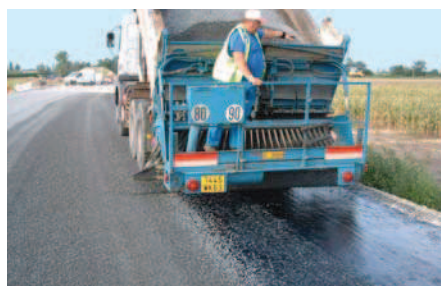
Application d'un enduit de cure.
