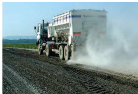
Traitement de la structure de chaussée au liant hydraulique routier.
