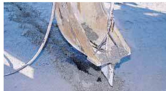
▲ La préfiissuration transversale au pas de 3 m fait appel à un outillage original conçu par l'entreprise.
