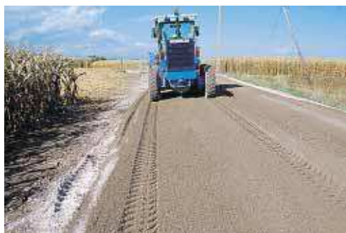
▲ Un premier malaxage est réalisé pour homogénéiser les matériaux.
