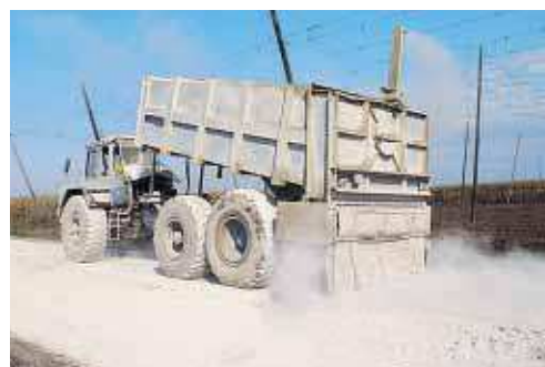
▲ Le liant routier ARC 3, livré par camion-citerne, est réparti avec précision au moyen d'un épandeur.
