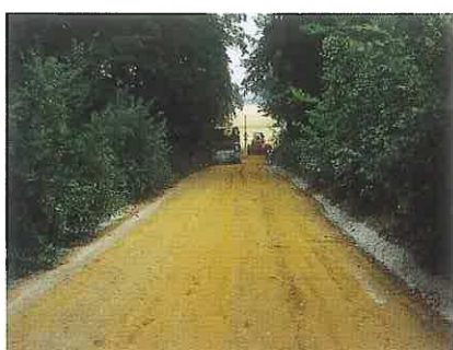
▲ Aspect de la chaussée après malaxage.
