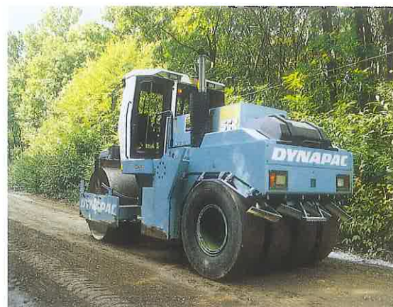
▲ Après un second malaxage, le sol est légèrement compacté.
