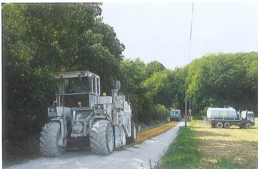
▲ D'une puissance de 531 ch, le RS 500 de CMI assure le malaxage des matériaux en place sur une profondeur de 45 cm.
