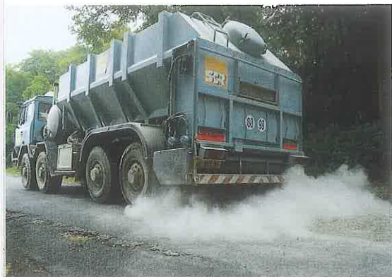
▲ L'épandeur (un camion équipé d'une cuve et d'un compresseur) réalise l'épandage du ciment directement sur l'ancienne chaussée à traiter.
