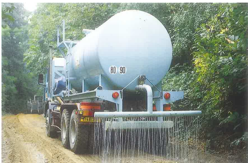
▲ Un camion muni d'une rampe d'arrosage permet d'ajuster la teneur en eau pour assurer une bonne hydratation du ciment.
