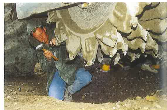
▲ Le malaxeur est muni d'un rotor sur lequel sont vissées 234 dents en tungstène afin de pouvoir broyer les matériaux de l'ancienne route. La nature très graveleuse des matériaux oblige à remplacer ces dents régulièrement.
