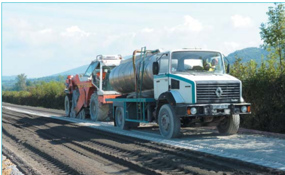
L'apport du liant hydraulique routier a été effectué par épandage. Au premier plan, la citerne-arroseuse procède à l'humidification. "L'eau est une ressource qu'il faut savoir gérer avec précision", rappelle Didier Desmoulin, directeur technique France chez Colas, pour "des raisons écologiques" mais aussi pour ne pas "ralentir inutilement l'atelier de traitement".
