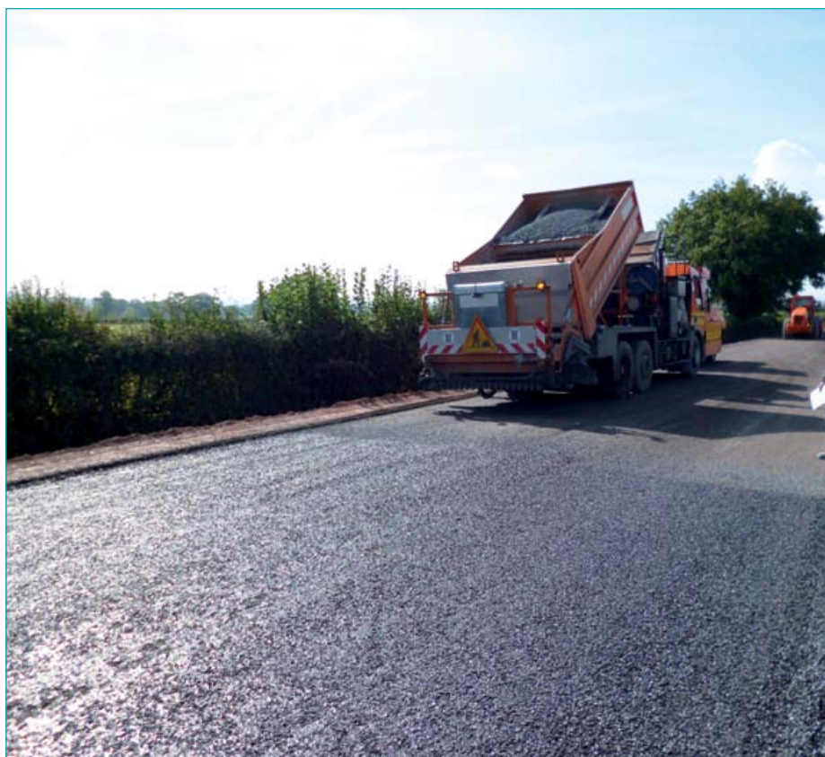
Après la réalisation de la protection superficielle, il ne restera plus qu'à parachever le chantier par la mise en place de la couche de roulement.
