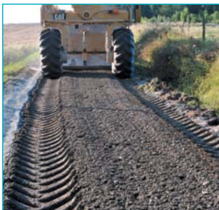
La niveleuse, munie de plusieurs rippeurs à l'arrière, permet à la fois de casser l'ancienne chaussée et de faire ressortir les plus gros galets.
