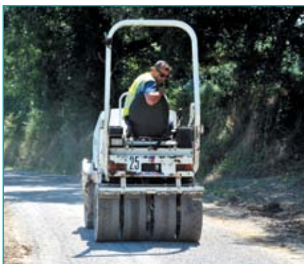
Finition, à l'aide d'un compacteur à roues, de la couche d'usure réalisée en enduit bicouche.
