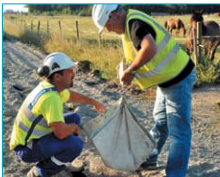
Contrôle, par simple pesée (essai dit "à la bêche"), de la régularité de l'épandage de liant hydraulique routier.
