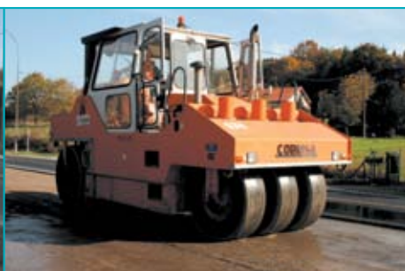
Deux phases de compactage successives (à gauche la première par compacteur vibrant, à droite la seconde par compacteur à pneus) permettent de densifier le matériau retraité.
