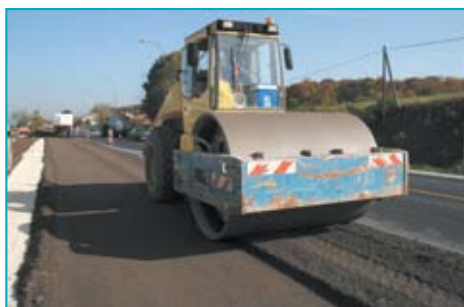
Deux phases de compactage successives (à gauche la première par compacteur vibrant, à droite la seconde par compacteur à pneus) permettent de densifier le matériau retraité.
