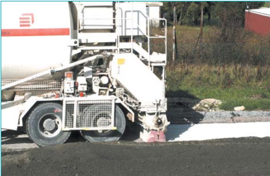
Installé à l'arrière d'un camion-citerne, un système de dosage automatisé déverse le liant hydraulique routier avec précision et régularité.
