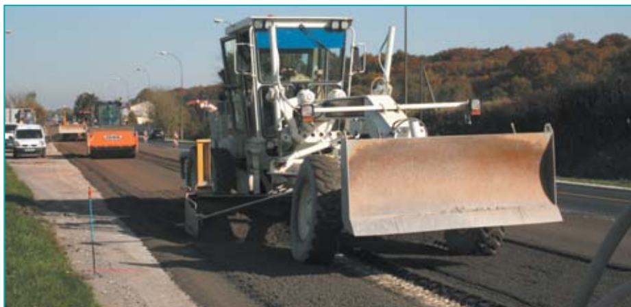
Le passage de la niveleuse permet d'obtenir une surface plane et de régler la couche à la hauteur définitive exigée.
