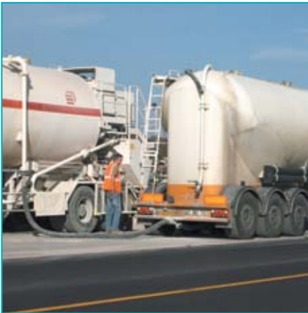
Rechargement de l'épandeur du liant hydraulique routier.
