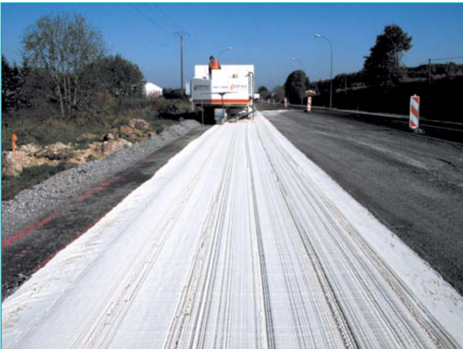
Le liant hydraulique routier a été appliqué sur la chaussée, préalablement scarifiée à la fraiseuse sur 28 cm d'épaisseur, juste avant le passage de l'ARC 1000.
