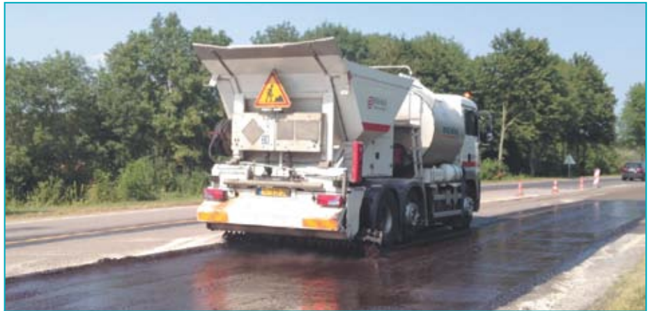
La pulvérisation de l'enduit de cure est destinée à protéger la couche retraitée des intempéries, de l'évaporation de l'eau et du trafic.
