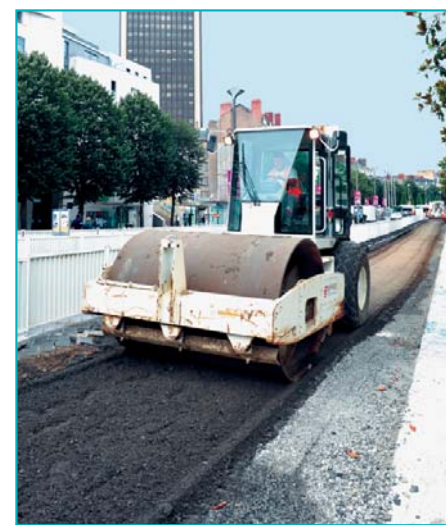
La phase de compactage suit le passage de la niveleuse.
