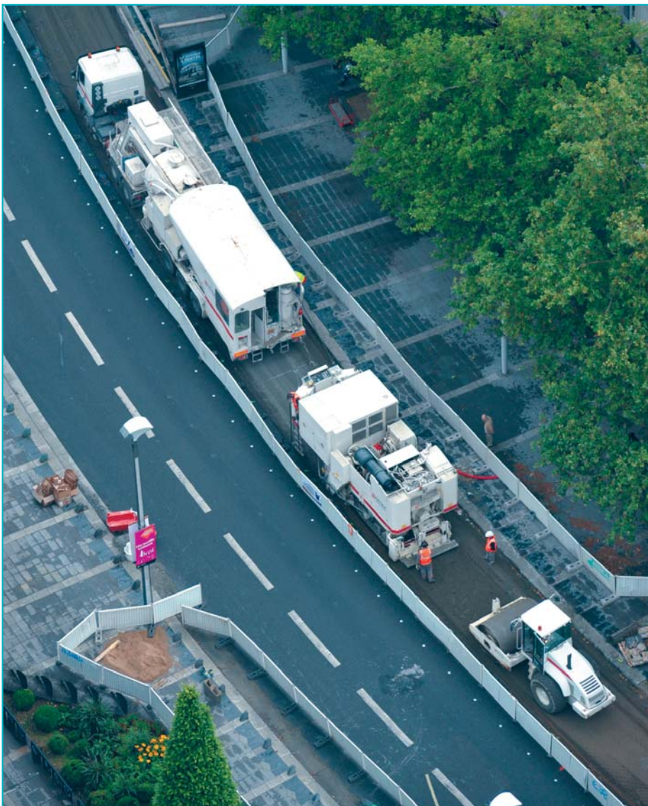
Vue aérienne de l'atelier mobile de retraitement en pleine action.
