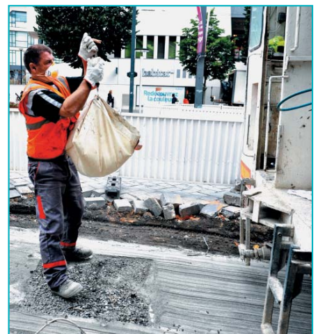
Le contrôle de la régularité de l'épandage et de la quantité de liant hydraulique routier est réalisé sur une surface témoin de 1 m 2 par la méthode dite « à la bâche ».
