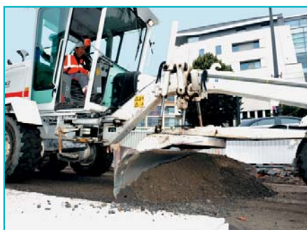
La niveleuse intervient juste après le passage du rotomalaxeur.
