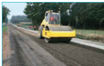
Le compactage suit immédiatement la phase de réglage.
