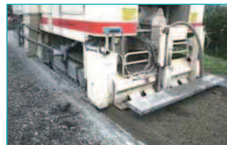
Malaxage en place de l'assise de l'ancienne chaussée, au moyen de liant hydraulique routier.
