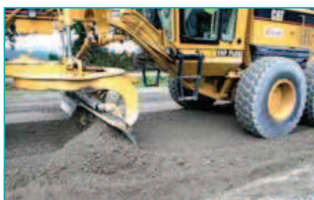
Réglage, à l'aide d'une niveleuse, de l'épaisseur de la chaussée malaxée.
